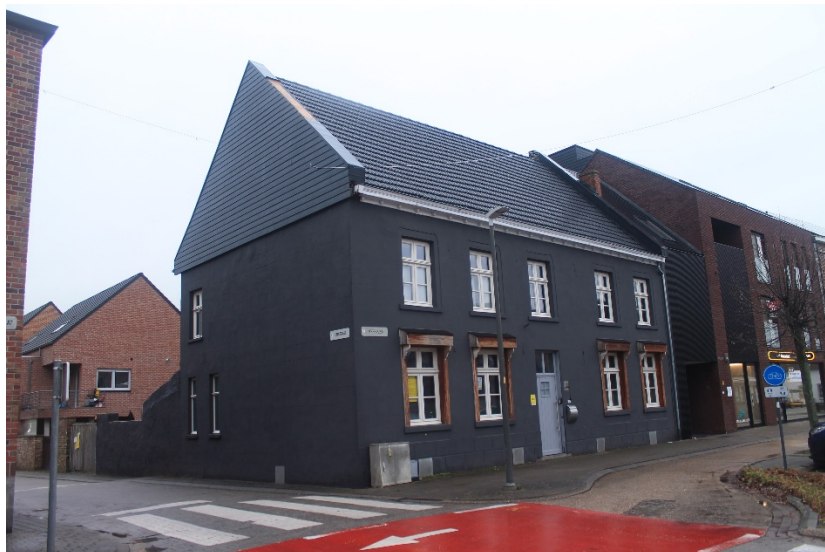
Foto 2: zicht vanop het Kerkplein vanuit het zuiden op de voor- en zijgevel van het monument, met links de Omstraat
