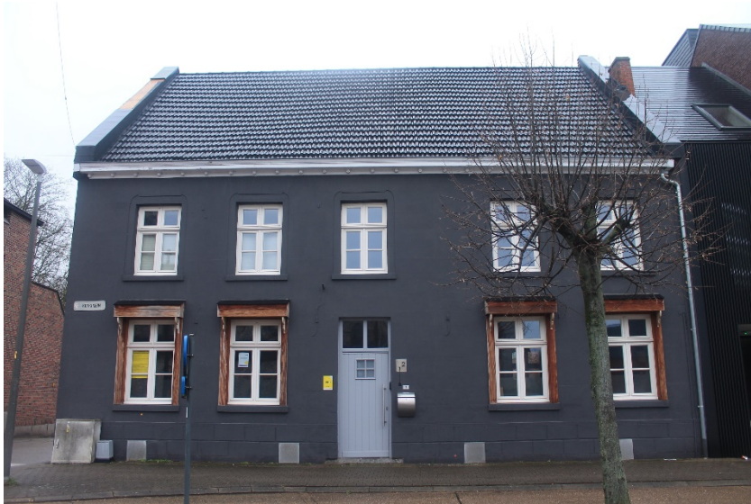
Foto 1: zicht vanop het Kerkplein vanuit het zuidoosten op de voorgevel van het monument
