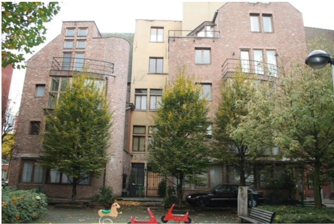
Foto 5: Zicht vanuit de Zirkstraat op het nieuwbouwcomplex van 1988.
