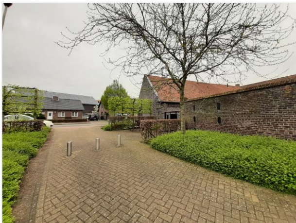
Foto 8: Hoeve Slichtenhof, Slichtestraat 5, toegang achtererf
