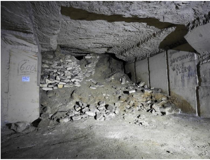
Foto 13. Instortingsgebied met pogingen tot stabilisatie met stenen
