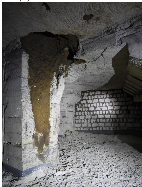
Foto 18. Aardpijp in een pilaar en scheidsmuur op de achtergrond van champignonteelt
