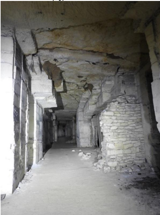
Foto 9. Landschap met gemetst muurtje van mergelstenen. Aan het plafond zijn enkele geologische verstoringen en aardpijpen zichtbaar
