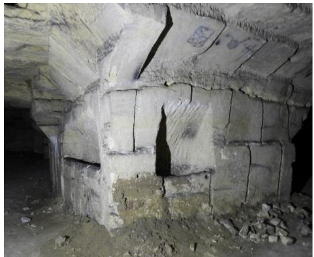
Foto 21. Sporen van secundair gebruik: twee voederbakken in een pilaar
