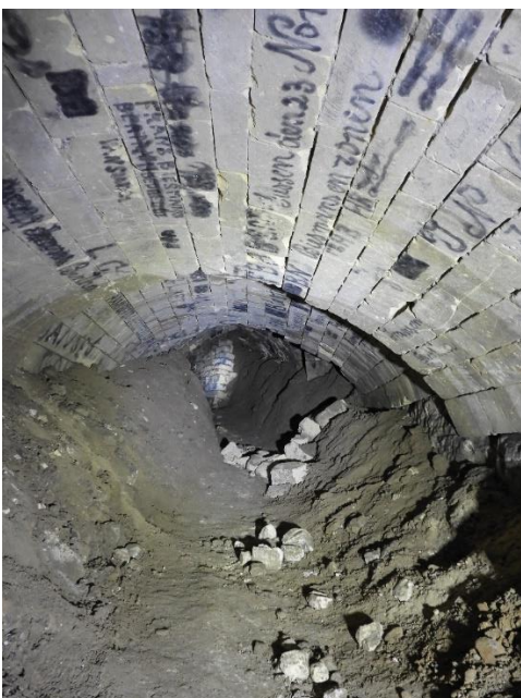
Foto 28. Toegangstunnel Stadtberg I
