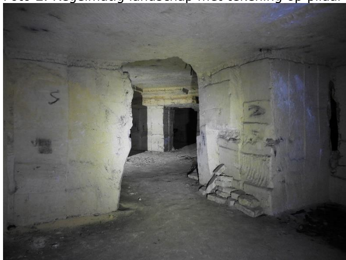
Foto 4. Doorbraak tussen twee stelsels, de pilaren en gangen staan dwars op elkaar
