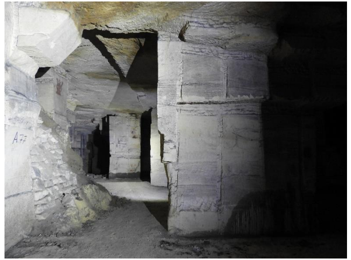
Foto 8. Gang met links een historische instorting die gestabiliseerd is met een muur van mergelstenen
