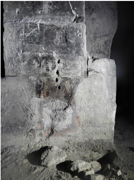
Foto 25. Vuurplaats met gaten erboven voor een stok waaraan een pot kon hangen
