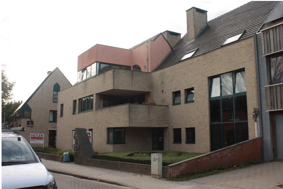
Foto 5: zicht vanop de Hoveniersstraat vanuit het oosten op het stadsgezicht
