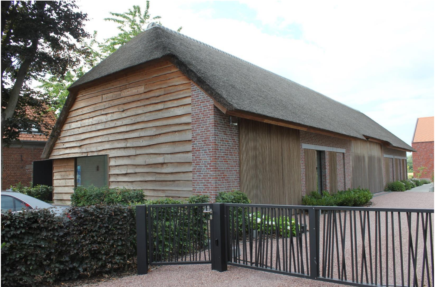
Foto 6: vroegere schuur van de voormalige hoeve Grouwsteenstraat 54A-B, 56.
