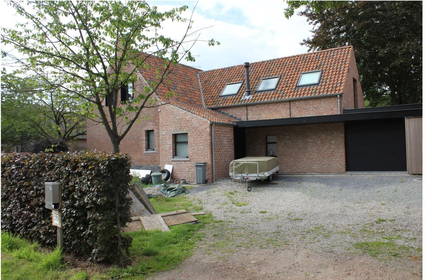
Foto 4: zij- en achtergevels van het woonhuis van de voormalige hoeve Grouwsteenstraat 54A-B, 56.
