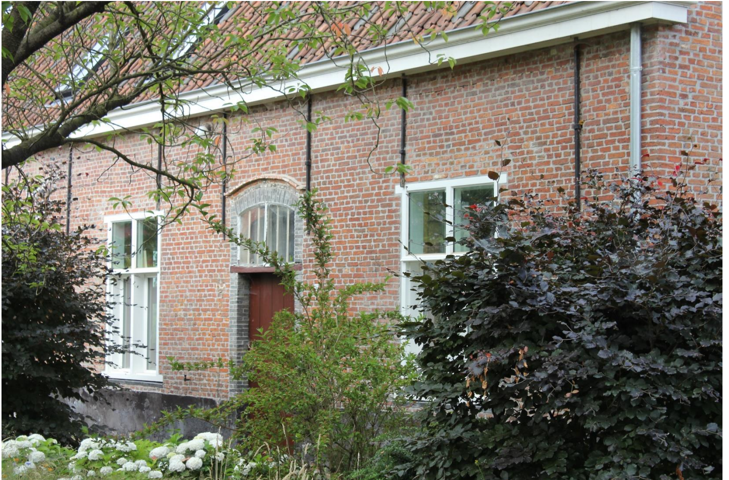
Foto 2: voorgevel van het woonhuis van de voormalige hoeve Grouwesteenstraat 54A-B, 56.
