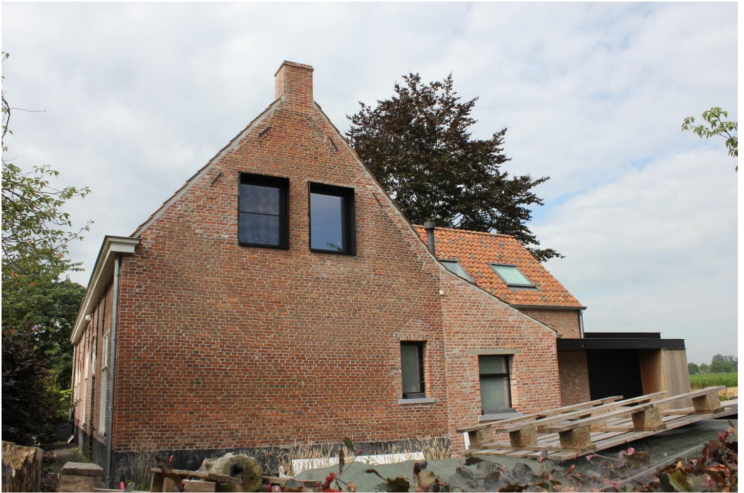
Foto 3: zijgevel van het woonhuis van de voormalige hoeve Grouwsteenstraat 54A-B, 56.
