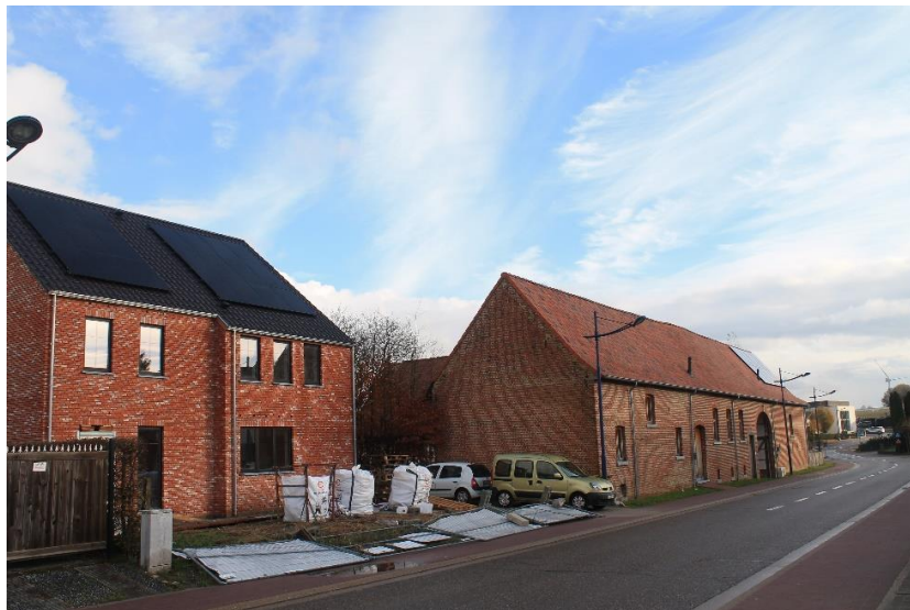
Foto 2: zicht vanop de Weyerstraat vanuit het noordwesten op de gesloten hoeve Het Paenhuys en het dorpsgezicht
