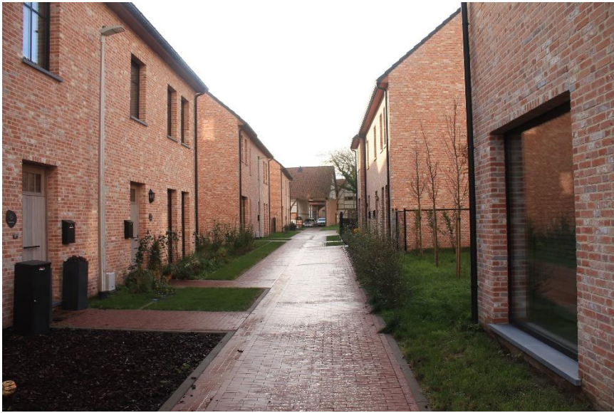
Foto 10: zicht vanop de Paenhuysstraat vanuit het noordoosten op de gesloten hoeve Het Paenhuys en het dorpsgezicht
