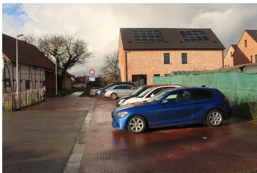
Foto 5: zicht vanop de Paenhuysstraat vanuit het zuidoosten op de gesloten hoeve Het Paenhuys en het dorpsgezicht
