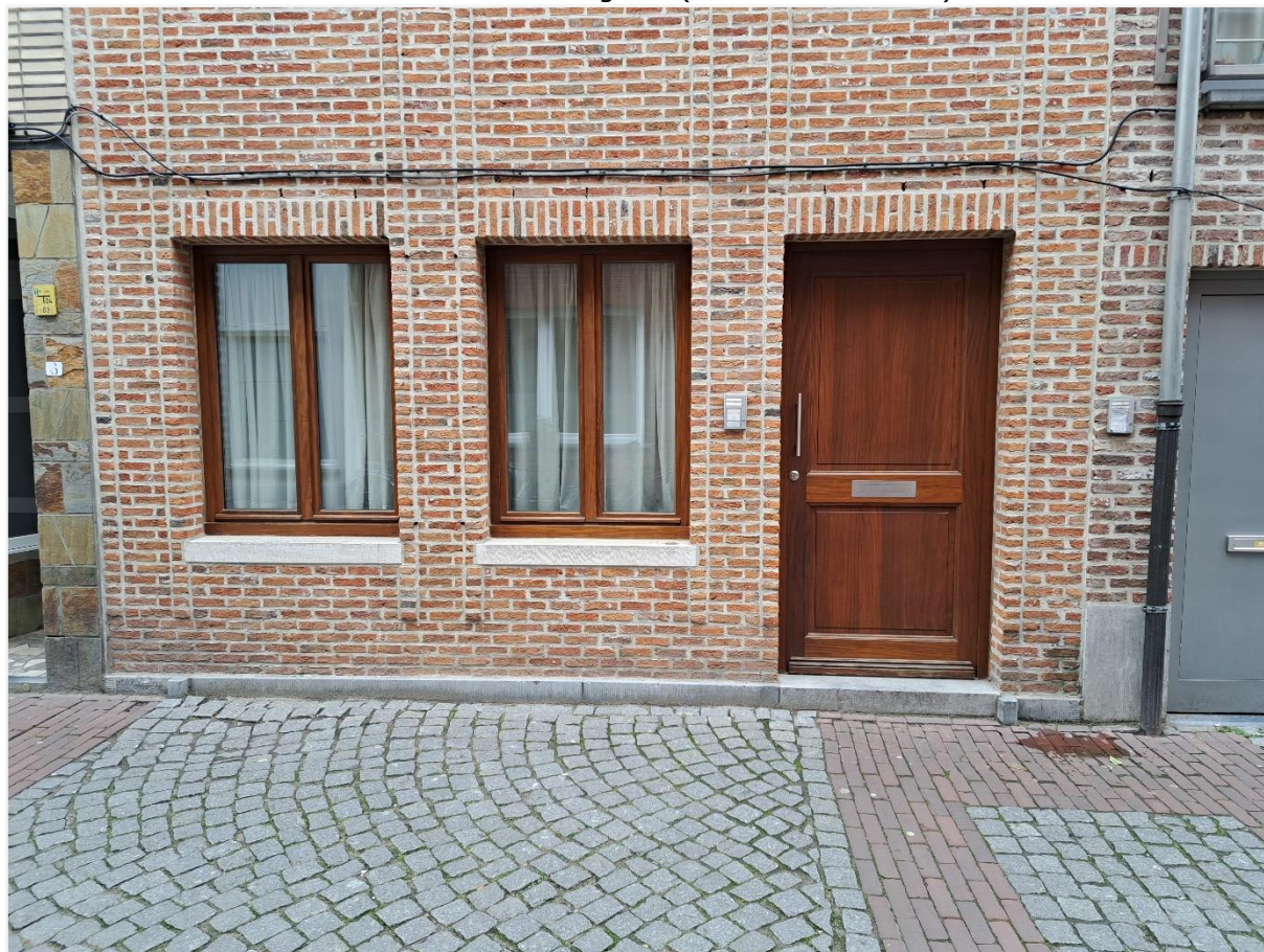
Foto 7: Detail gevel gelijkvloers (15 december 2023)
