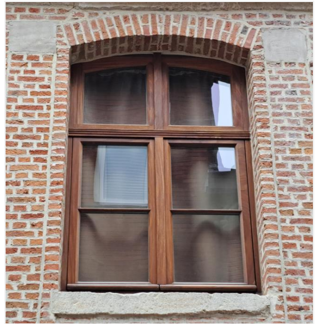
Foto 9: Raam eerste verdieping (15 december 2023)
