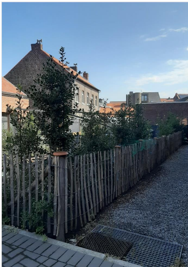
Foto 11: Binnengebied ten noorden van de nieuwbouw van 2015-2016, met kapelanie (hoog gebouw, Vaesstraat 4) dat binnen de afbakening van de bescherming als monument blijft.
