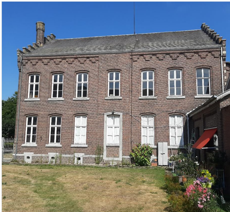
Foto 12: Binnengebied ten noorden van de nieuwbouw van 2015-2016 met grasveld en achtergevel van de Dekenij die binnen de afbakening van de bescherming als monument blijven. Via hekje aan linkerzijde van de dekenij heeft men toegang tot de rest van de als monument beschermde tuin (nu gekend als 'Hof van de Deken').
