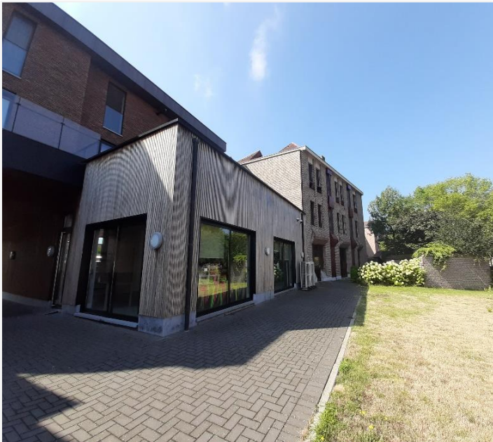
Foto 7: Achterzijde van de nieuwbouw die in 2015-2016 gerealiseerd werd op een deel van de vroegere tuin van het refugiehuis. Rechts daarvan achtergevel van Grauwe Torenwal 9. Grasveld en achterliggend tuintje hoort tot het binnengebied en blijft binnen de afbakening van de bescherming als monument.
