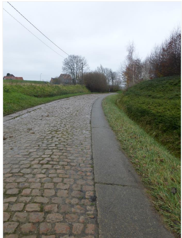
Foto 4: De kasseiweg wordt afgeboord met betonplaten en een langsgracht.
