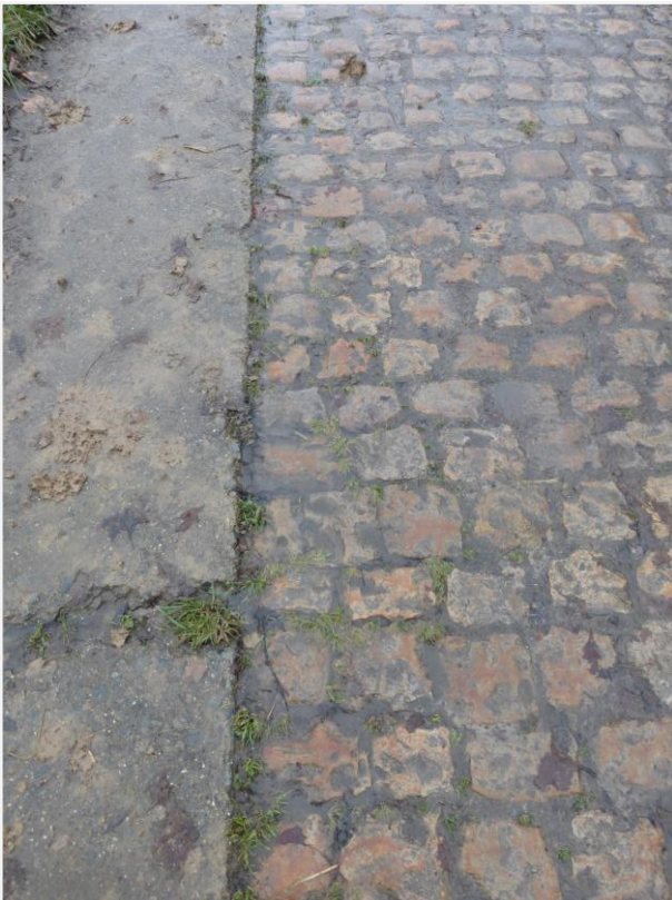
Foto 7: De kasseiweg wordt afgeboord door betonplaten.
