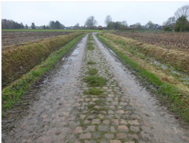
Foto 3: De kasseiweg met uitgesproken bolrond wegprofiel.
