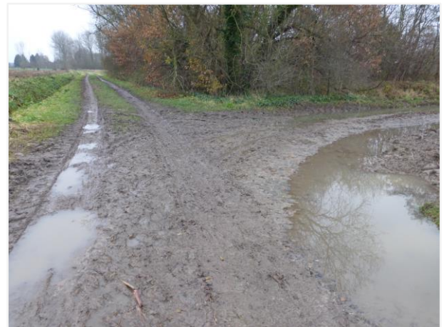
Foto 4: De kasseiweg gaat naar het noordwesten over in een onverharde losweg.
