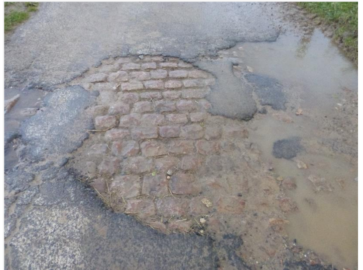
Foto 10: De kasseien zijn bewaard onder de asfaltlaag bij Hoeksken.
