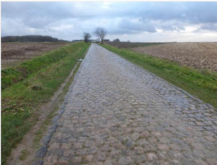
Foto 3: Boordstenen in Petit Granit en parallelle langsrachten.
