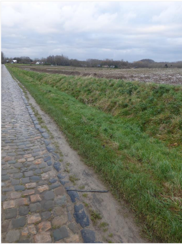
Foto 5: Grasberm en langsgracht.
