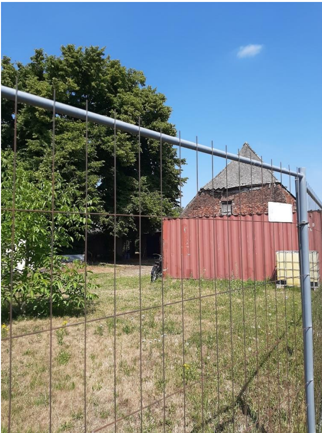
Foto 4: De zuidzijde van Hoespooren gezien vanaf de straat Loberg, ter hoogte van de ingestorte schuur, 29 juli 2022.
