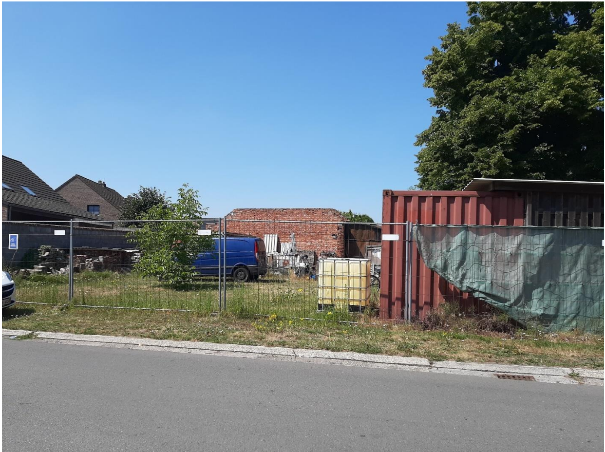
Foto 3: Het perceel 54V van de ingestorte schuur gezien vanaf de straat Loberg, 29 juli 2022.
