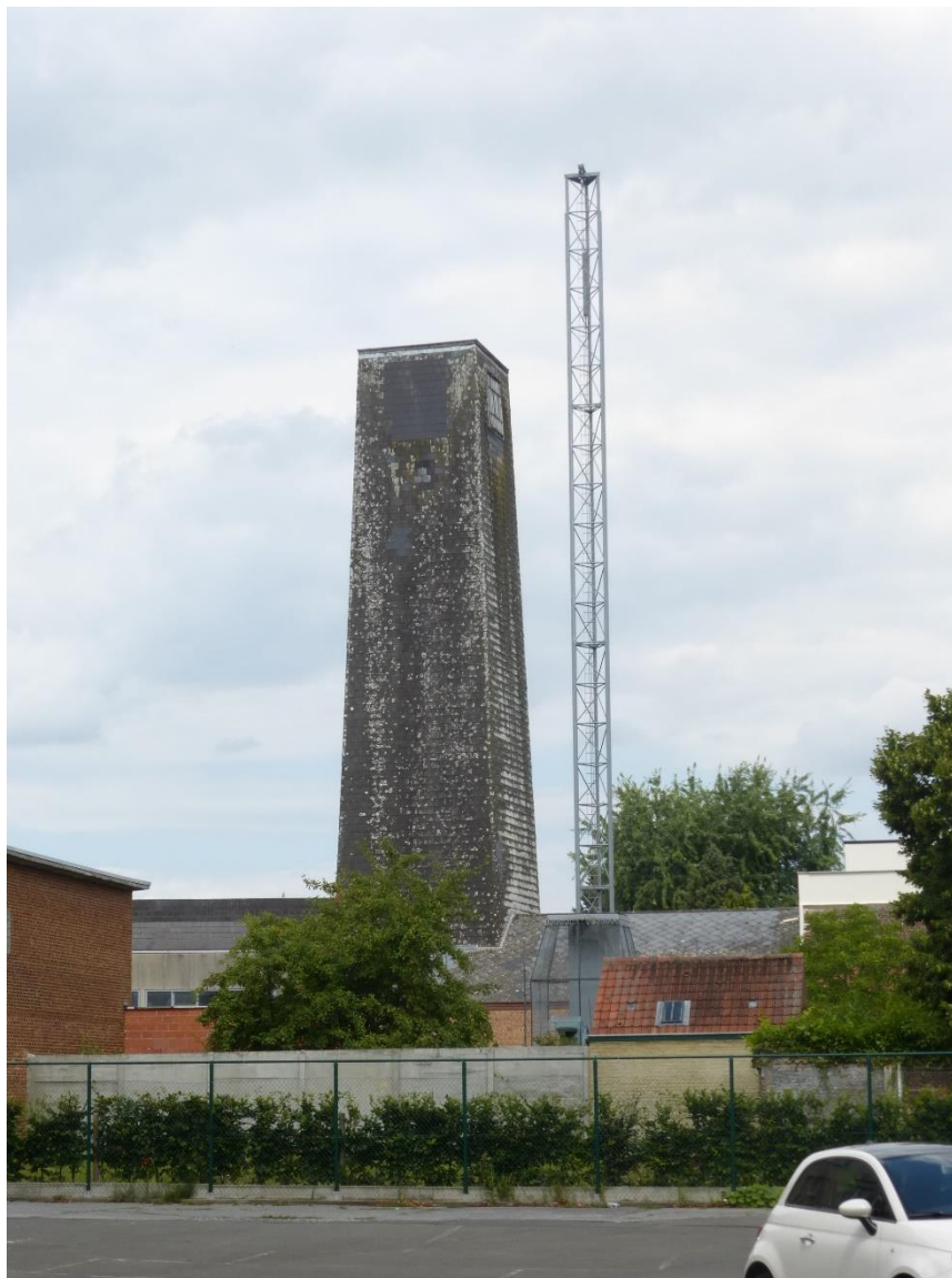
Foto 2: zicht op de schutterstoren vanuit het zuiden (Sint-Pietersnieuwstraat). Het dichtgemaakte raam in de zuidzijde van de top is nog afleesbaar aan de minder verkleurde leien. Het raam met venster is aan de oostzijde bewaard (plaatsbezoek Onroerend Erfgoed 26.07.2023).
