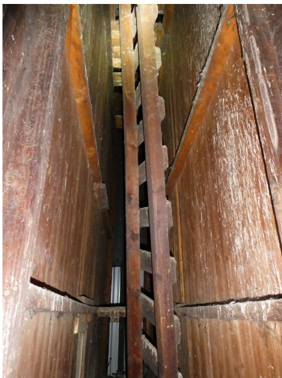
Foto 18-19: inspectieschacht bereikbaar via een houten zolderluik vanaf de begane grond. Zicht op de metalen skeletconstructie met daarop houten verticale kepers. De verschillende niveaus hebben meestal geen tussenvloer. Rechts: houten ladder in inspectieschacht tussen wanden met houten bebording (18: plaatsbezoek Onroerend Erfgoed 16.05.2022 -19: rapport Monumentenwacht, Wim Meers, plaatsbezoek 30.01.2023, © Monumentenwacht).
