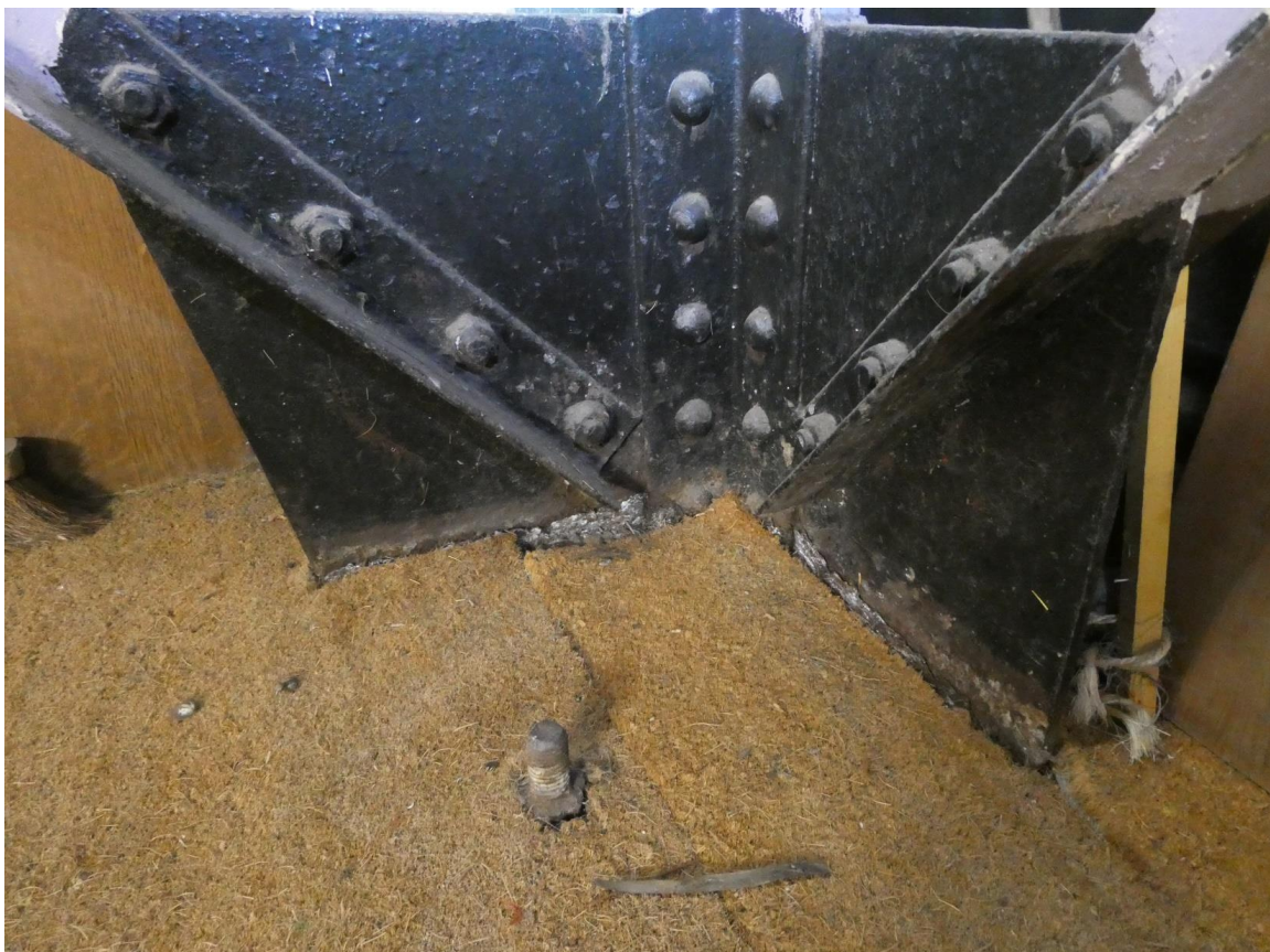
Foto 38: de vier hoekpilonen zijn stevig verankerd in betonnen fundamenteen en bijkomend met (schroef)bouten verstevigd (rapport Monumentenwacht, Wim Meers, plaatsbezoek 30.01.2023, © Monumentenwacht).
