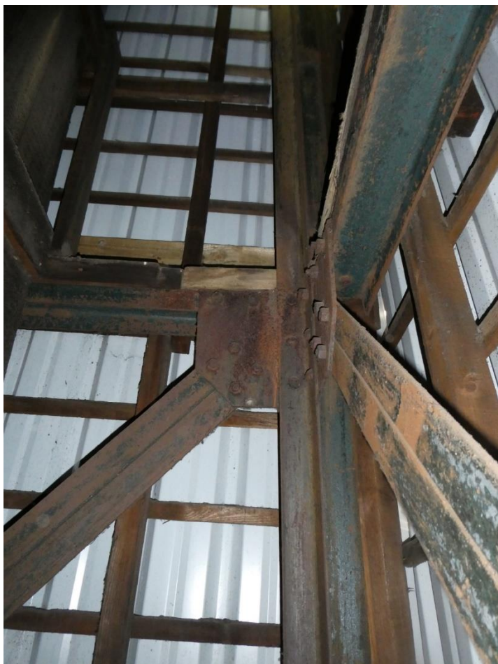
Foto 22-23: inspectieschacht: de metalen hoekverbindingen (knooppunten van verticale pilonen, horizontale liggers en diagonale verstevigingen) zijn met (schroef)bouten verankerd – op de metalen buitenconstructie zijn houten verticale kepers geplaatst waarop oorspronkelijk de kunstleien bevestigd waren (rapport Monumentenwacht, Wim Meers, plaatsbezoek 30.01.2023, © Monumentenwacht).
