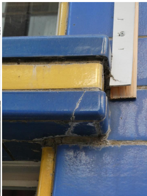
Foto 16-17: de pui van de voormalige herberg "In de Toewip". Links: detail profieltegels bij portaal. Rechts: detail profieltegels bij druiplijst tussen de ramen en de bovenlichten (rapport Monumentenwacht, Wim Meers, plaatsbezoek 30.01.2023, © Monumentenwacht).
