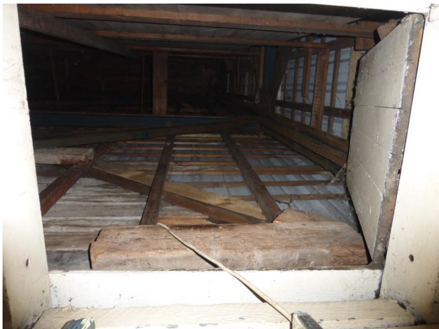
Foto 18-19: inspectieschacht bereikbaar via een houten zolderluik vanaf de begane grond. Zicht op de metalen skeletconstructie met daarop houten verticale kepers. De verschillende niveaus hebben meestal geen tussenvloer. Rechts: houten ladder in inspectieschacht tussen wanden met houten bebording (18: plaatsbezoek Onroerend Erfgoed 16.05.2022 -19: rapport Monumentenwacht, Wim Meers, plaatsbezoek 30.01.2023, © Monumentenwacht).
