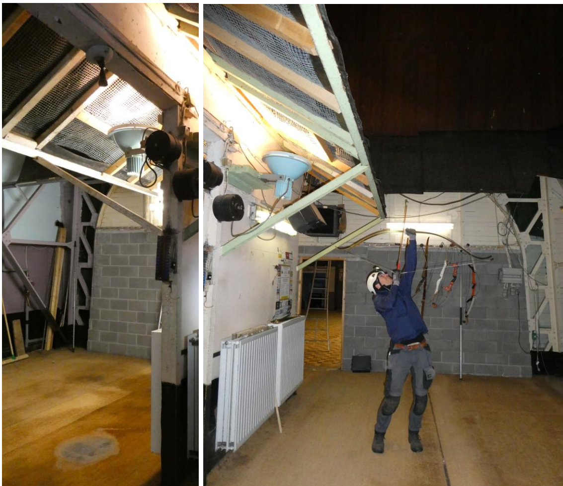
Foto 36-37: samengesteld beeld: links de westelijke schuttersvloer, rechts de oostelijke. Afdaken (lessenaarsdak) met ijzerdraad om pijlen op te vangen (rapport Monumentenwacht, Wim Meers, plaatsbezoek 30.01.2023, © Monumentenwacht).
