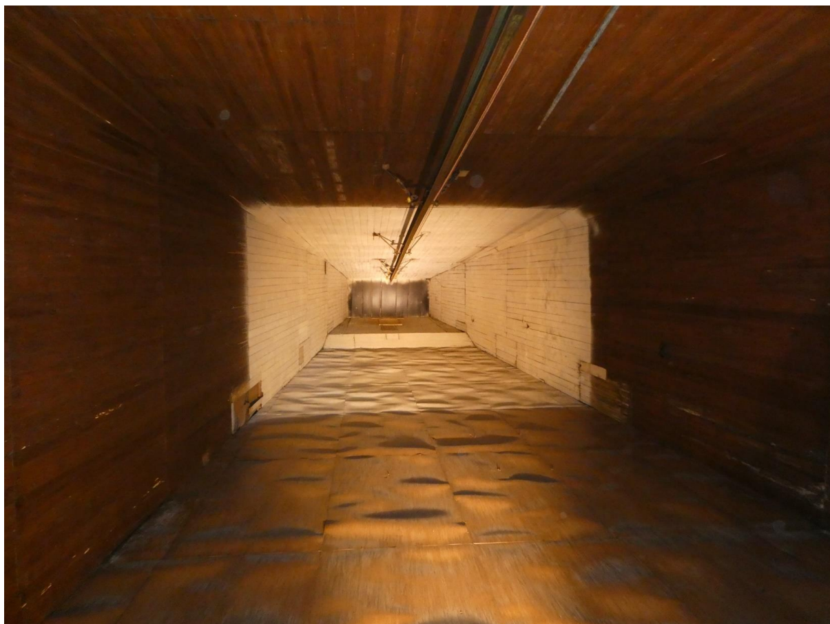
Foto 42: zicht op één van de binnentorens met metalen staande wip. Grotendeels verticale beplanking. De binnenluiken geven de positie van de vroegere ramen aan (rapport Monumentenwacht, Wim Meers, plaatsbezoek 30.01.2023, © Monumentenwacht).
