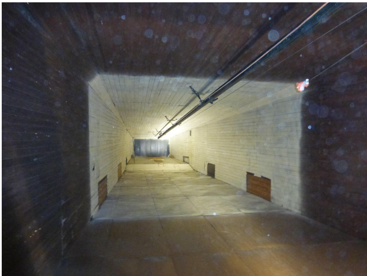
Foto 41: zicht op één van de binnentorens met metalen staande wip. Grotendeels verticale beplanking. De binnenluiken geven de positie van de vroegere ramen aan (plaatsbezoek Onroerend Erfgoed 16.05.2022).
