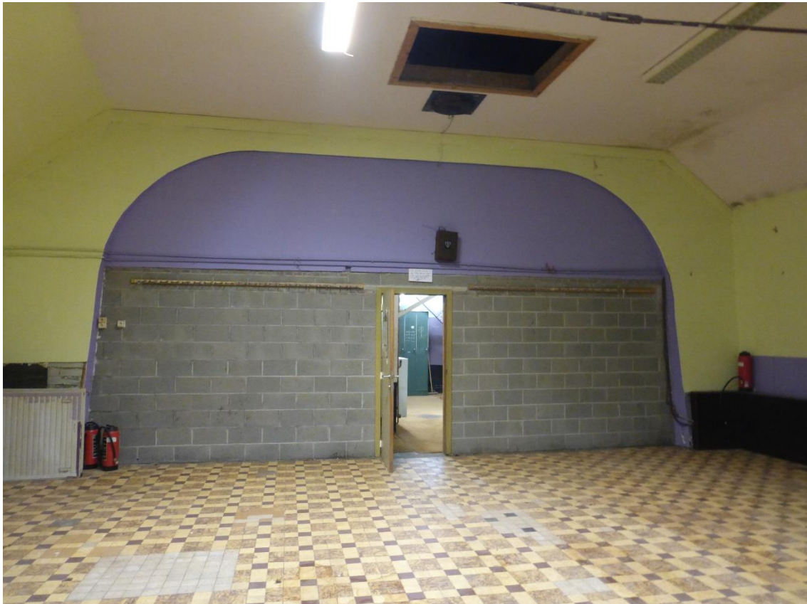
Foto 27: de toegang tot de schutterstoren vanuit de niet mee beschermde gelagzaal gebeurt via een brede korfboog (plaatsbezoek Onroerend Erfgoed 16.05.2022).
