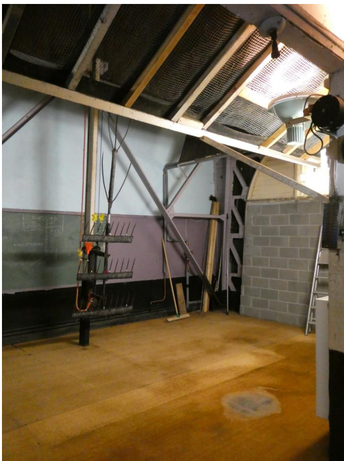
Foto 33-34: links: de noordwand van de schutterstoren ter hoogte van de overgang naar de gelagzaal. De zones tussen de korfboogconstructie en de pilonen zijn verstevigd met een metalen straalwerk. In de hoeken van de noordwand loopt de horizontale bebording verder. Rechts: de westelijke wand met overgang naar de noordwand met korfboog. Afdak met ijzerdraad om pijlen op te vangen bij het schieten naar de wip (33: plaatsbezoek Onroerend Erfgoed 16.05.2022 – 34: rapport Monumentenwacht, Wim Meers, plaatsbezoek 30.01.2023, © Monumentenwacht).
