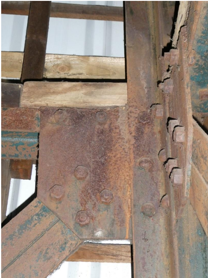
Foto 22-23: inspectieschacht: de metalen hoekverbindingen (knooppunten van verticale pilonen, horizontale liggers en diagonale verstevigingen) zijn met (schroef)bouten verankerd – op de metalen buitenconstructie zijn houten verticale kepers geplaatst waarop oorspronkelijk de kunstleien bevestigd waren (rapport Monumentenwacht, Wim Meers, plaatsbezoek 30.01.2023, © Monumentenwacht).
