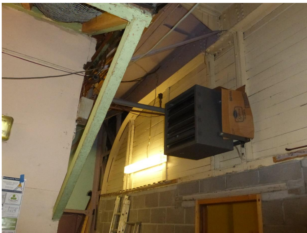
Foto 32: de noordwand van de schutterstoren met gebogen metalen constructie, ter hoogte van de overgang naar de gelagzaal. Het boogveld is ingevuld met metalen stijlen en een horizontale houten beplanking, het onderste deel was oorspronkelijk open (recente invulling met betonstenen) (plaatsbezoek Onroerend Erfgoed 16.05.2022).
