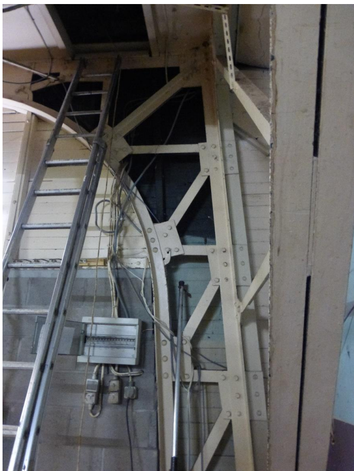
Foto 33-34: links: de noordwand van de schutterstoren ter hoogte van de overgang naar de gelagzaal. De zones tussen de korfboogconstructie en de pilonen zijn verstevigd met een metalen straalwerk. In de hoeken van de noordwand loopt de horizontale bebording verder. Rechts: de westelijke wand met overgang naar de noordwand met korfboog. Afdak met ijzerdraad om pijlen op te vangen bij het schieten naar de wip (33: plaatsbezoek Onroerend Erfgoed 16.05.2022 – 34: rapport Monumentenwacht, Wim Meers, plaatsbezoek 30.01.2023, © Monumentenwacht).
