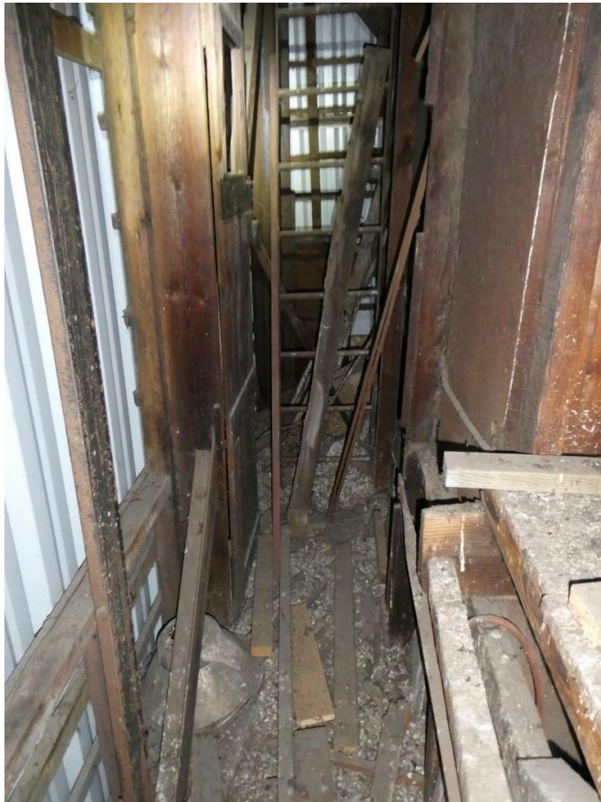
Foto 20-21: verankerde metalen ladders in de inspectieschachten (rapport Monumentenwacht, Wim Meers, plaatsbezoek 30.01.2023, © Monumentenwacht).
