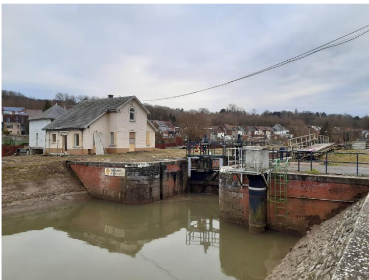
Foto 9: De sluis en het sashuis
