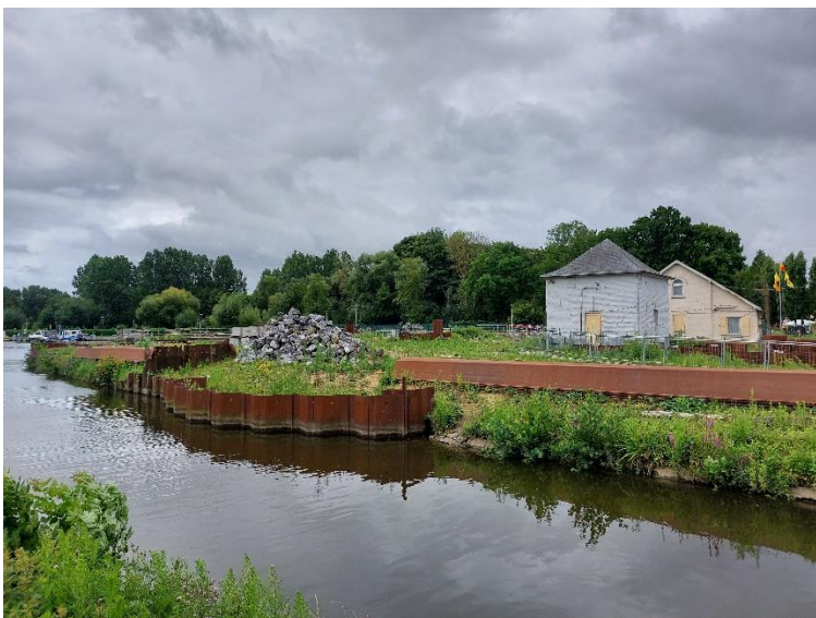
Foto 18: Arm naar kleine stuw, bedieningsgebouw van grote stuw en sashuis
