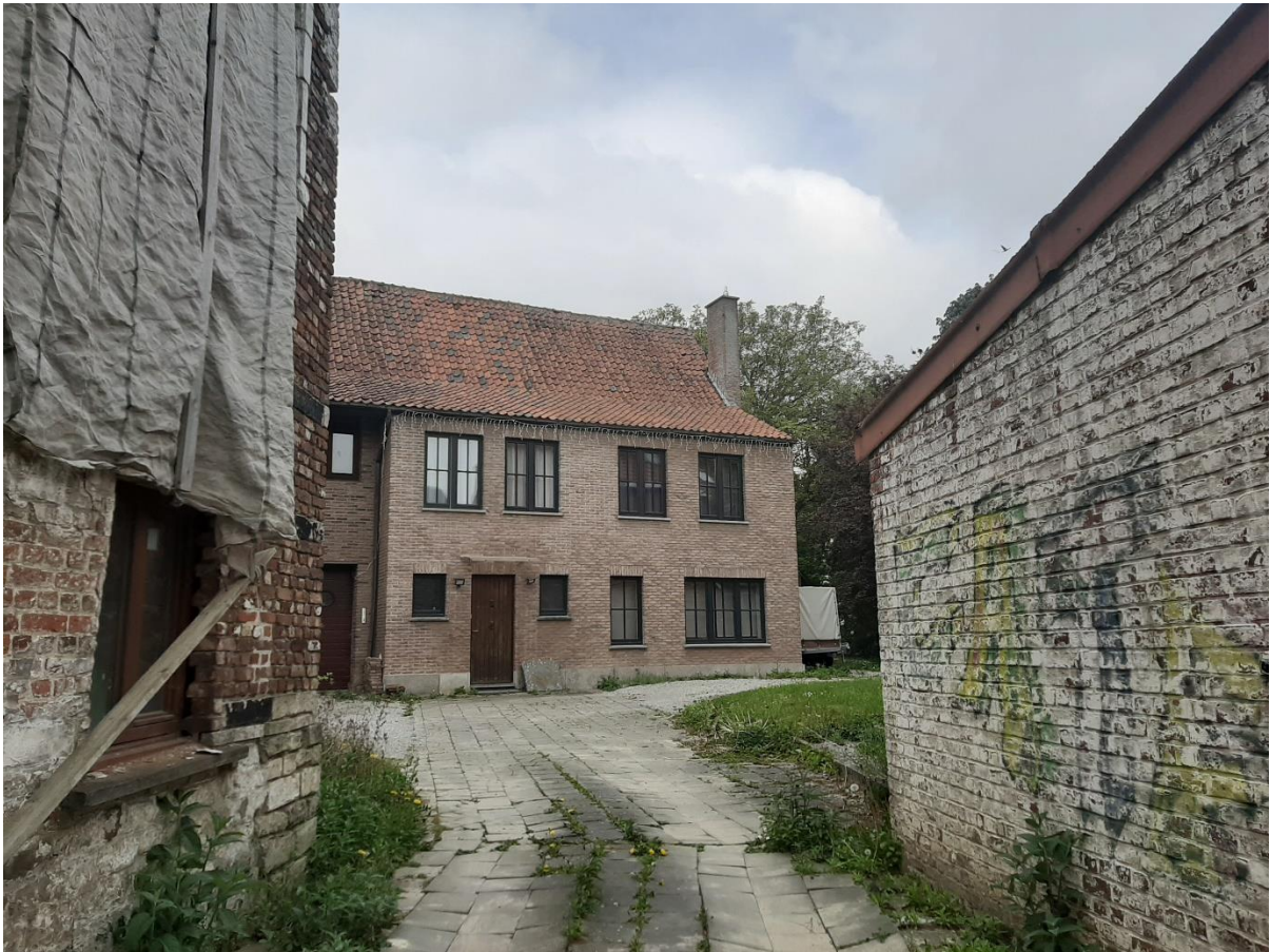
Foto 5: Zicht op de woning Verlatstraat nummer 14 opgenomen in het beschermd stadsgezicht.
