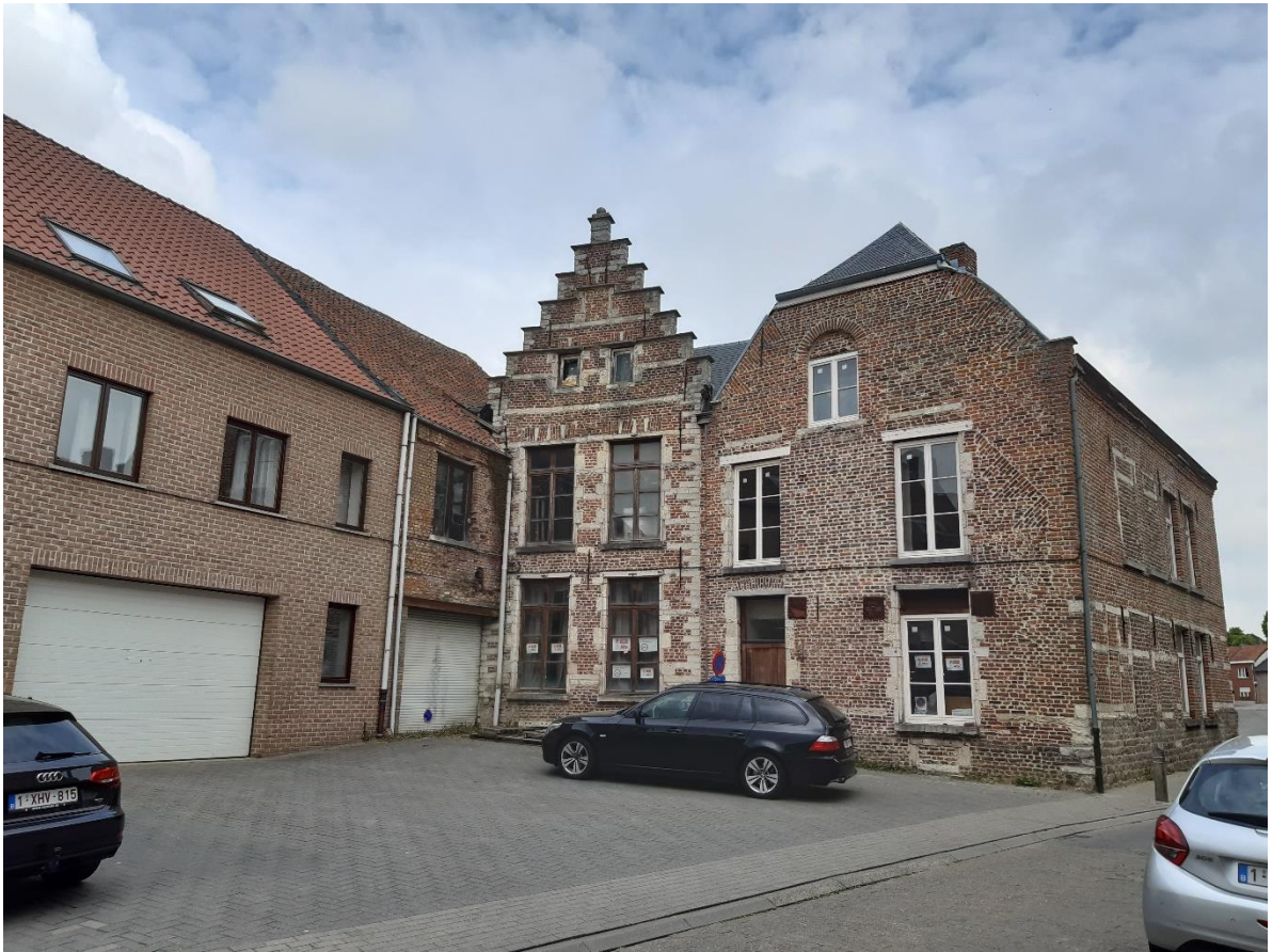
Foto 1: Zicht op het beschermd monument Verlatstraat nummer 12, het beschermd stadsgezicht Verlatstraat nummer 4 en het voorliggend pleintje.
