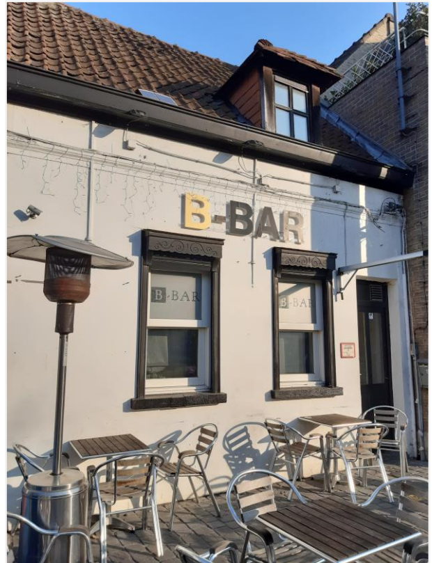
Foto 4: Dorpswoning, Drongenplein 15 bepleisterde lijstgevel met overschilderde rolluikkasten en kroonlijst (© agentschap Onroerend Erfgoed 24 maart 2022).
