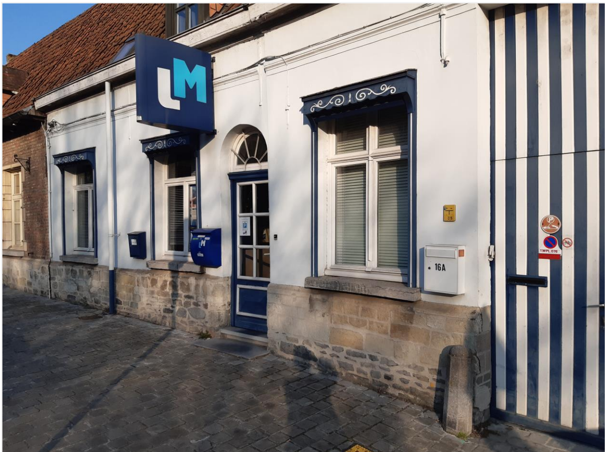
Foto 2: Dorpswoning, Drongenplein 16-16A in Drongen: bepleisterde lijstgevel op zandstenen plint met bewaard buitenschrijnwerk (© agentschap Onroerend Erfgoed 24 maart 2022).
