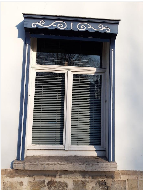
Foto 5: Dorpswoning, Drongenplein 16-16A: detail venster met rolluikkast (© agentschap Onroerend Erfgoed 24 maart 2022).
