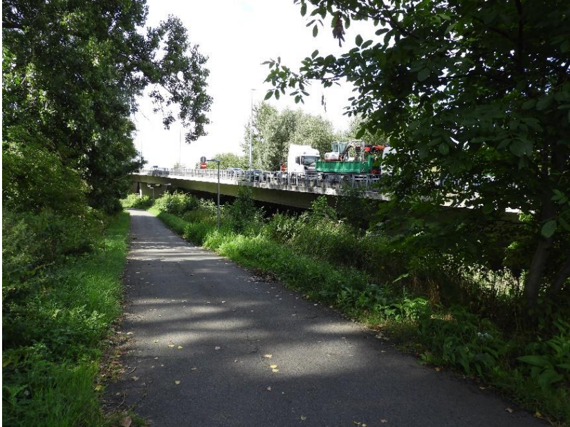
Foto 4: fietsverbinding ten zuidwesten van de brug van de R8
