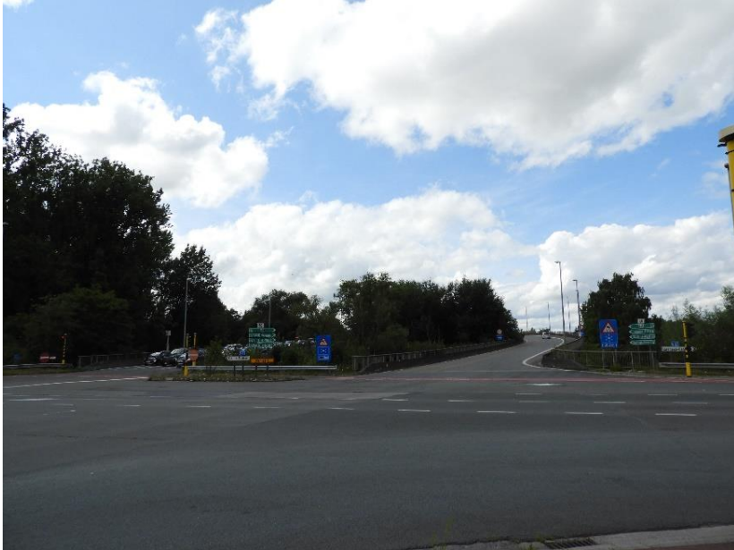
Foto 1: brug van de R8 over de Leie
