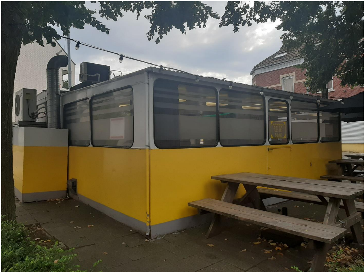
Foto 5: Frietkot aan de Albertlaan gezien vanuit noordoostelijke hoek.
