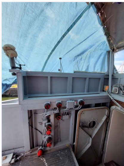
Foto 23: bakboordzijde met vernieuwde opstand
