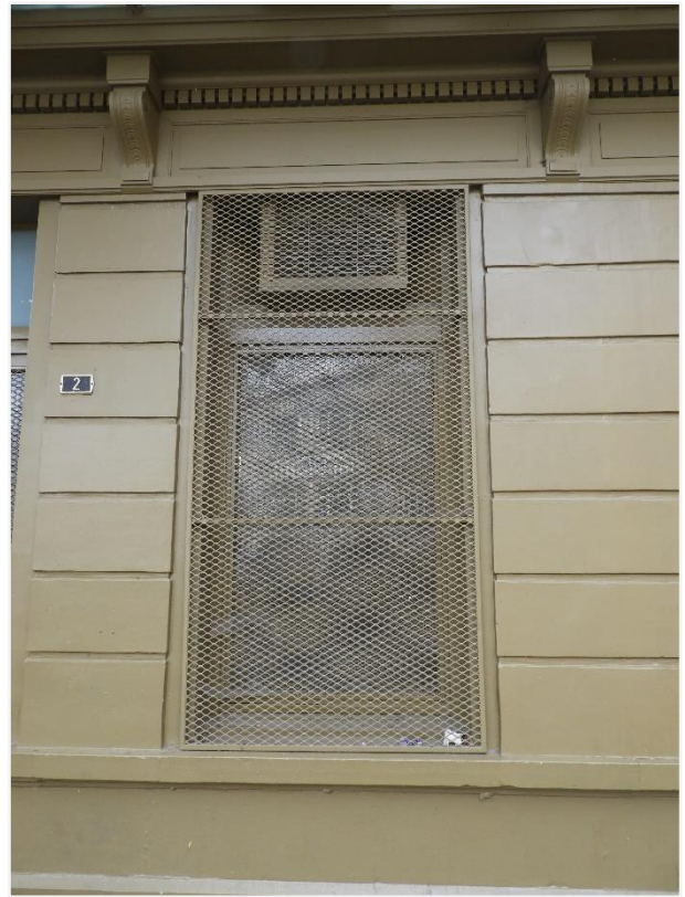
Foto 9: Begane grond. Detail venster en bepleisterde gevel in imitatiebossage (Biekorfstraat).
