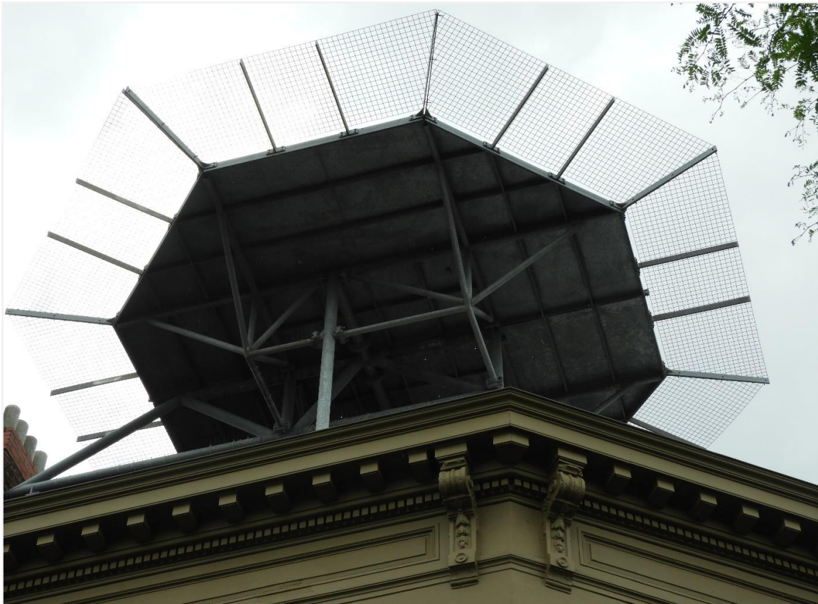
Foto 2: Bekronend helikopterplatform naar ontwerp van architect Deleu geplaatst in 2011.
