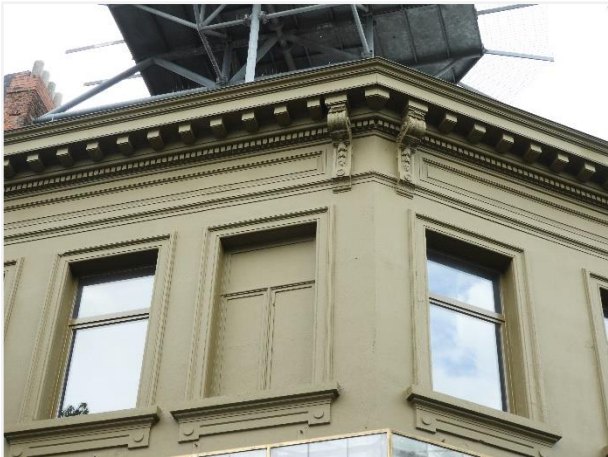
Foto 3: Tweede verdieping eind-19de-eeuwse gevelafwerking (Biekorfstraat).
