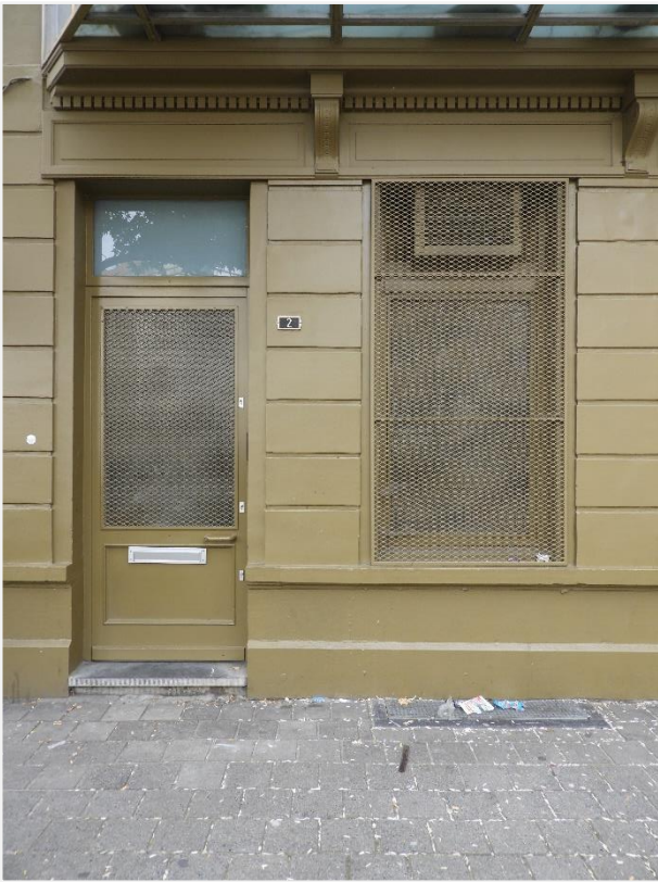
Foto 8: Begane grond, met verplaatste voordeur (Biekorfstraat).
