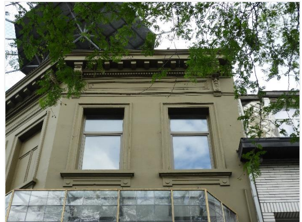
Foto 4: Tweede verdieping eind-19de-eeuwse gevelafwerking (Trapstraat).
