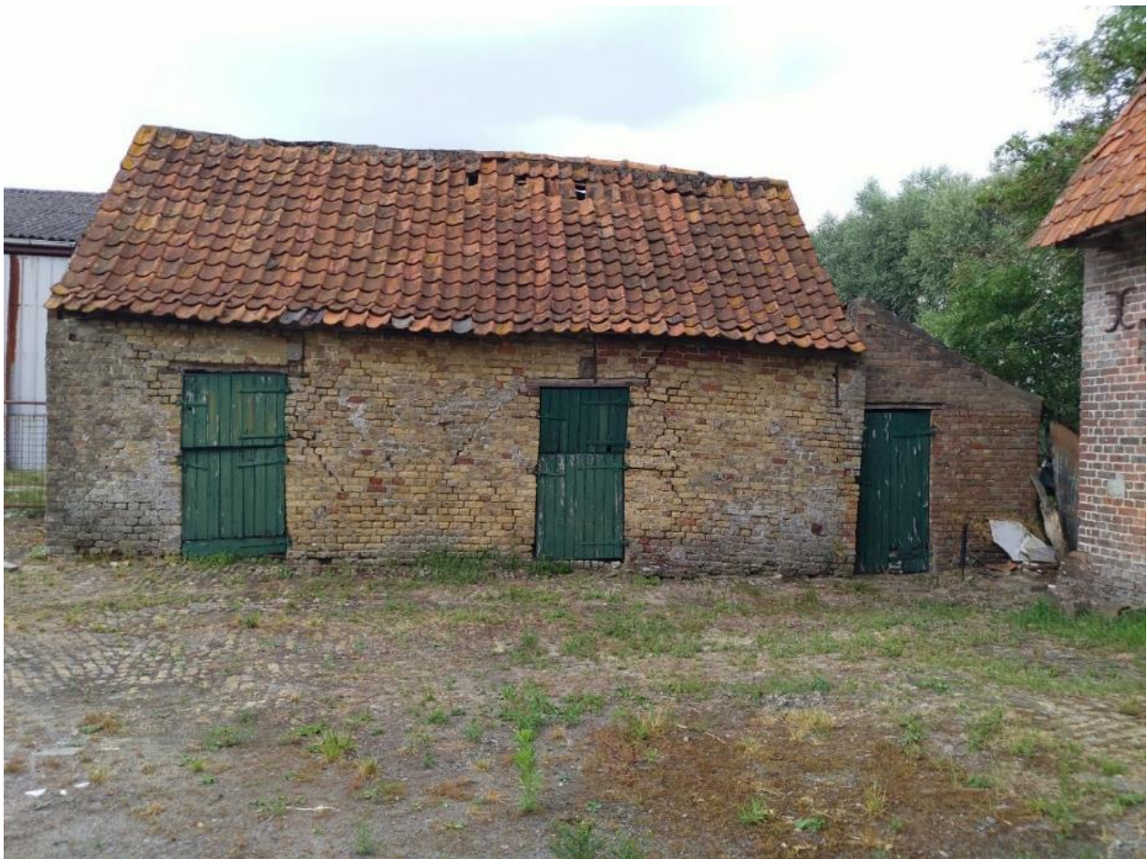
Foto 62: de jaarlingenstal op het neerhof heeft twee houten, tweeledige staldeuren onder houten latei. Rechts is een stalletje onder lessenaarsdak aangebouwd. Erfverharding van bakstenen op hun kant, onder meer voor weggetjes over het neerhof (deels met aarde overdekt) (plaatsbezoek Onroerend Erfgoed 23.06.2023).
