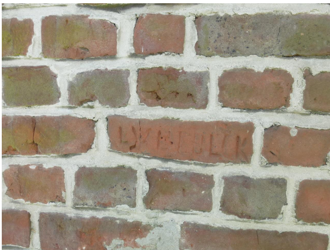
Foto 54: in de noordelijke traveeën van de achtergevel bewaart een baksteen een ingebakken ingekerfde naam, mogelijk van een steenbakker (plaatsbezoek Onroerend Erfgoed 17.05.2024).
