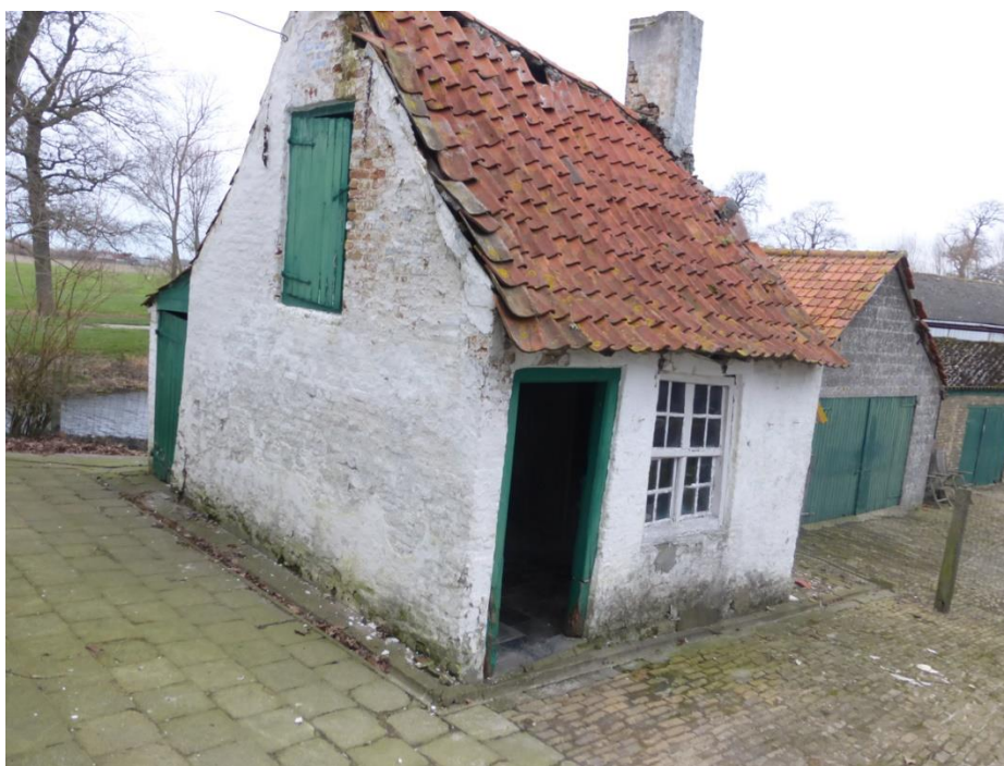
Foto 36: zijgevel van de werkruimte (bakhuis) met groengeschilderd houten laadvenster in het gevelveld (kozijnconstructie). Erfverharding van bakstenen op hun kant. Zicht op de walgracht (plaatsbezoek Onroerend Erfgoed 31.01.2024).
