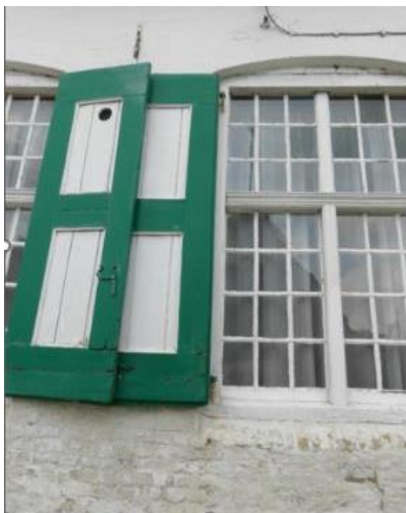
Foto 19: bij de kruisvensters van het hooghuis zijn zowel de benedenvakken (3 vakken in de breedte, 4 in de hoogte) met schuifvensters als de bovenlichten voorzien van kleine roedeverdelingen (3 x 3 vakken). De hoge opgeklampte luiken zijn groen- en witgeschilderd (plaatsbezoek Onroerend Erfgoed 23.06.2023).
