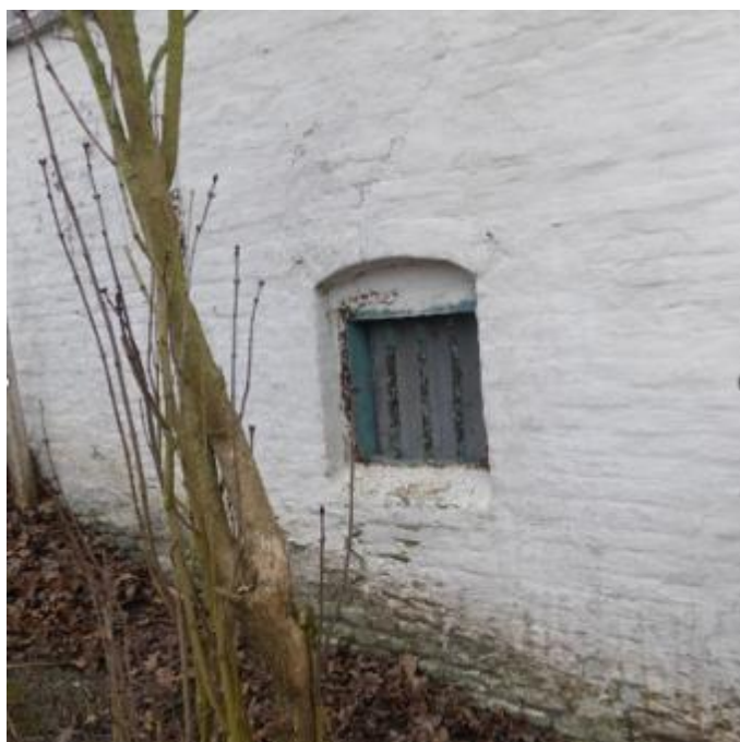
Foto 23: het rechthoekige keldervenster in de naar het neerhof gerichte gevel (hooghuis) is gevat in een steekboognis. Groengeschilderd enkel kozijnvenster met diefijzers en binnenluiken (plaatsbezoek Onroerend Erfgoed 17.01.2024).
