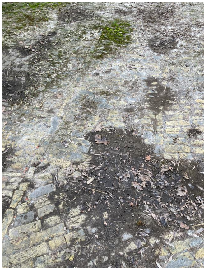
Foto's 67-68: de erfaanleg in de hoek van het erf tussen de jaarlingenstal en de schuur. De bestrating van bakstenen op hun kant is van dito afvoergoten voorzien (plaatsbezoek Onroerend Erfgoed 17.01.2024).
