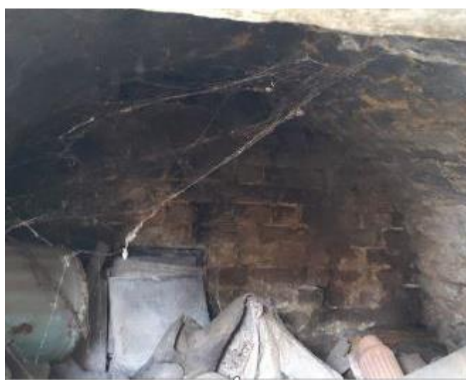
Foto 40: het lagere bakovengebouwtje waarin de oven ingebouwd is. Onderaan geeft een houten luikje toegang tot een droogruimte voor houtbussels: houten luik met smeedijzeren hang- en sluitwerk (kozijnconstructie) opslagruimte (plaatsbezoek Onroerend Erfgoed 23.06.2023).
