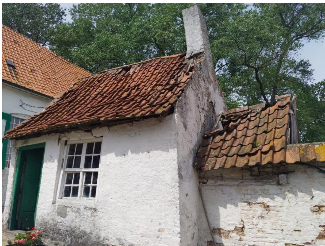
Foto 34: het bakhuis van het tweeledige type (zuidzijde) – links de hogere werkruimte – rechts het lagere bakovengebouwtje, op smallere plattegrond – zadeldaken met rode Vlaamse pannen (plaatsbezoek Onroerend Erfgoed 23.06.2023).
