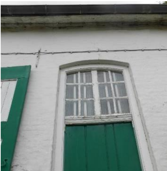
Foto 16: de voordeur met bovenlicht van het hooghuis is gevat in een houten, geprofileerd kozijn. Boven het geprofileerde kalf steekt het tweeledige bovenlicht met kleine roedeverdeling (2 vakken in de breedte, 3 in de hoogte) en diefijzers (plaatsbezoek Onroerend Erfgoed 23.06.2023).
