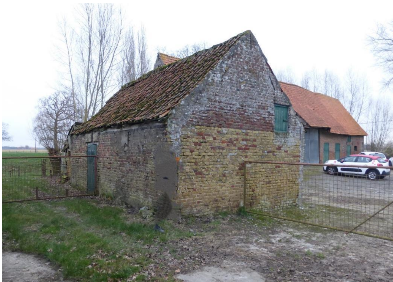
Foto 66: achtergevel en zijgevel van de jaarlingenstal op het neerhof. In de westelijke zijgevel valt het kleurverschil van de baksteen op: beneden oude gele baksteen - gevelveld in rode baksteen met houten luikje (kozijnconstructie). De rode baksteen vervangt mogelijk stijl- en regelwerk met plankenbeschieting zoals bewaard bij de oostelijke zijgevel (plaatsbezoek Onroerend Erfgoed 17.01.2024).
