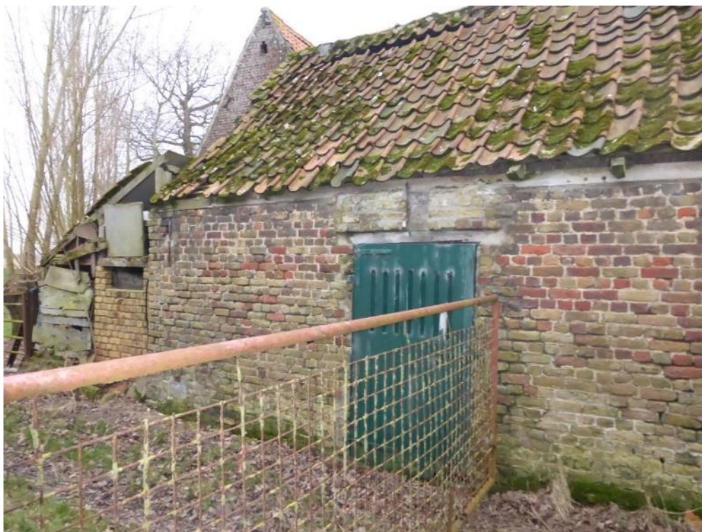
Foto 65: jaarlingenstal op het neerhof, achtergevel. Houten staldeur onder houten latei. Aangebouwd stalletje onder lessenaarsdak met deels bewaarde plankenbeschieting. Ook de roodbakstenen zijgevel van de schuur met uilengat komt in beeld (plaatsbezoek Onroerend Erfgoed 17.01.2024).
