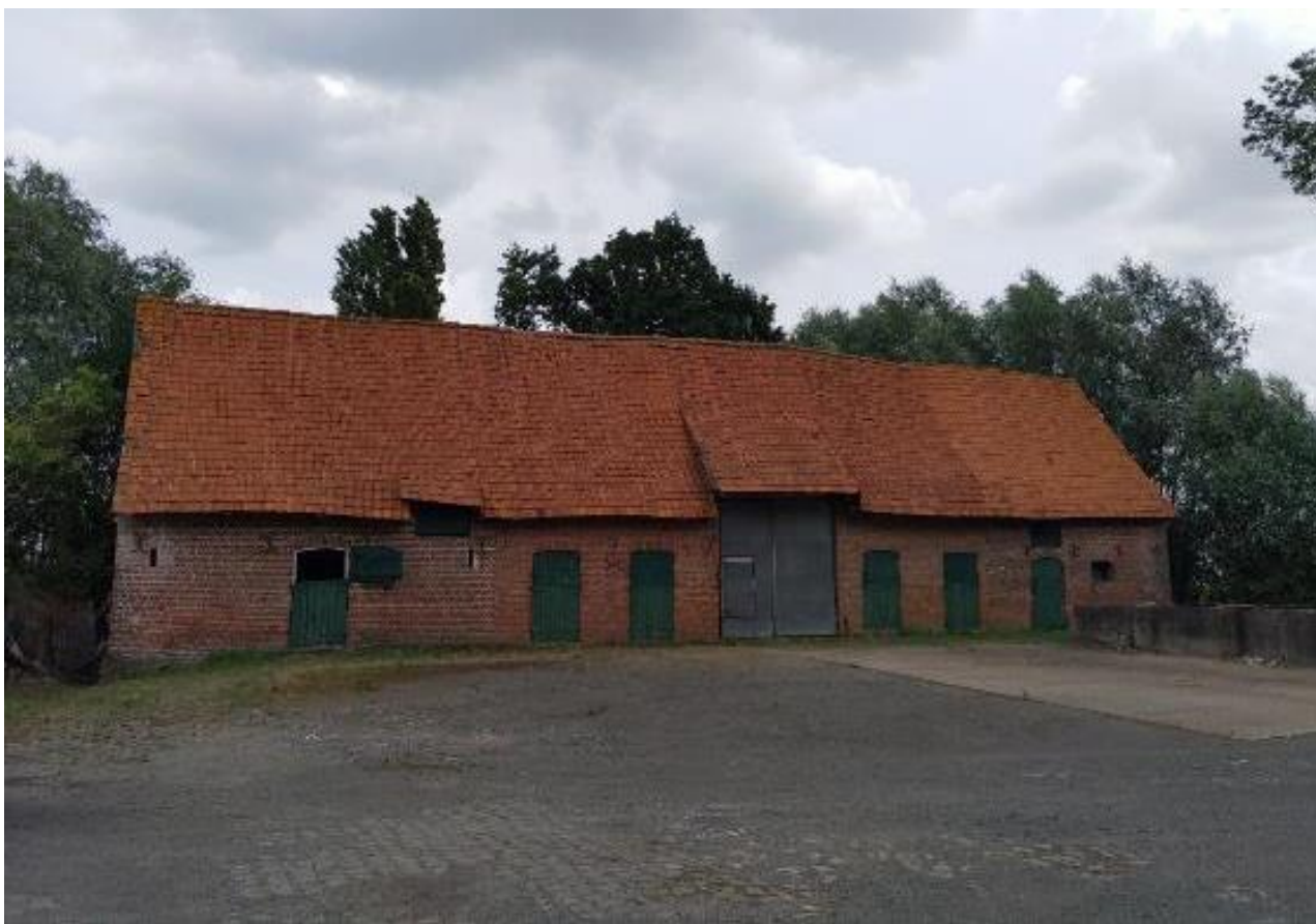
Foto 44: dwarsschuur in verankerde rode baksteenbouw, gevat onder zadeldak (rode mechanische pannen). Licht asymmetrische gevelopbouw van de erfgevel: de hoge schuurpoort onder een hogere dakoverstek, ongeveer in het midden, is geflankeerd door telkens drie staldeuren. Twee bewaarde houten laadvensters, links onder verhoogde dakoverstek. Het erf is deels verhard met kasseien en deels met bakstenen op hun kant. Onder de steenslagverharding, links van de schuurpoort, zijn de bakstenen muren van de vroegere mestvaalt bewaard (plaatsbezoek Onroerend Erfgoed 23.06.2023).
