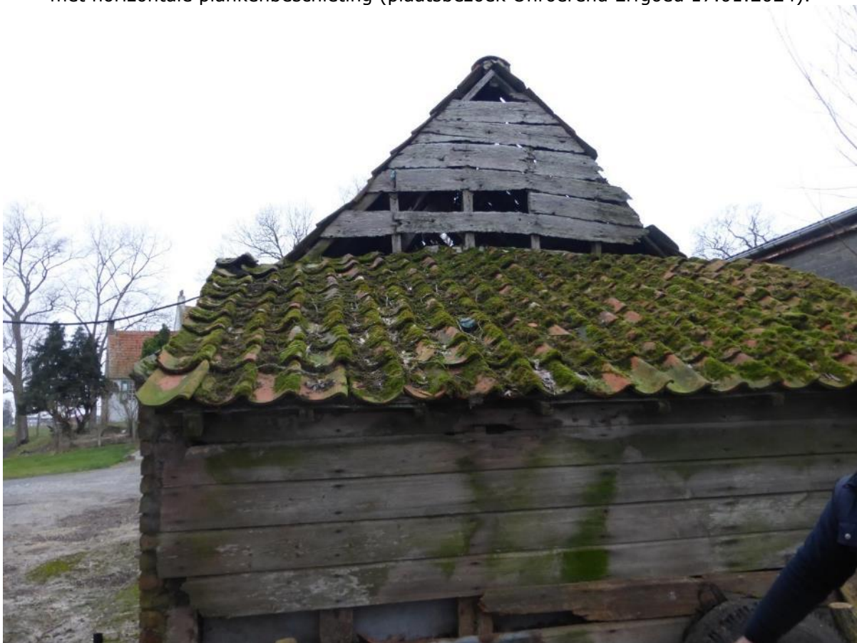
Foto 64: de oostelijke zijgevel van de jaarlingenstal op het neerhof bewaart in het gevelveld stijl- en regelwerk met horizontale plankenbeschiëting. Ook het aangebouwd stalletje onder lessenaarsdak (rode Vlaamse pannen) heeft een zijgevel in stijl- en regelwerk met plankenbeschiëting (plaatsbezoek Onroerend Erfgoed 17.01.2024).
