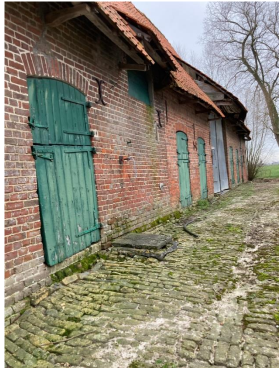
Foto's 67-68: de erfaanleg in de hoek van het erf tussen de jaarlingenstal en de schuur. De bestrating van bakstenen op hun kant is van dito afvoergoten voorzien (plaatsbezoek Onroerend Erfgoed 17.01.2024).
