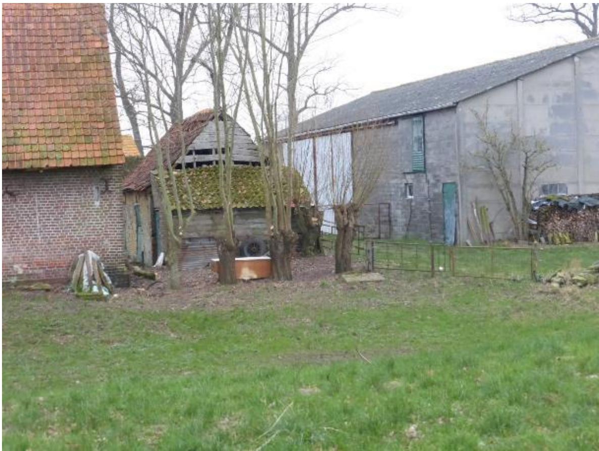
Foto 63: de oostelijke zijgevel van de jaarlingenstal op het neerhof bewaart in het gevelveld stijl- en regelwerk met horizontale plankenbeschiëting (plaatsbezoek Onroerend Erfgoed 17.01.2024).
