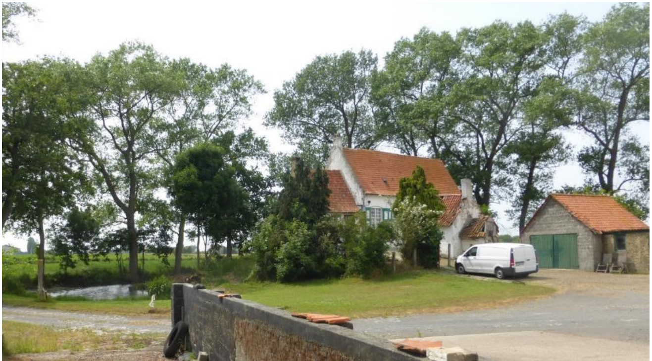
Foto 10: zicht vanaf het neerhof op het omgrachte, opgehoogde opperhof met het hooghuis en het aanleunende laaghuis. Haaks op de nok van het hoge en steile zadeldak van het hooghuis is het bakhuis ingeplant. Kenmerkend voor de gebouwen op het opperhof is de witgekalkte, verankerde baksteenbouw (plaatsbezoek Onroerend Erfgoed 23.06.2023).
