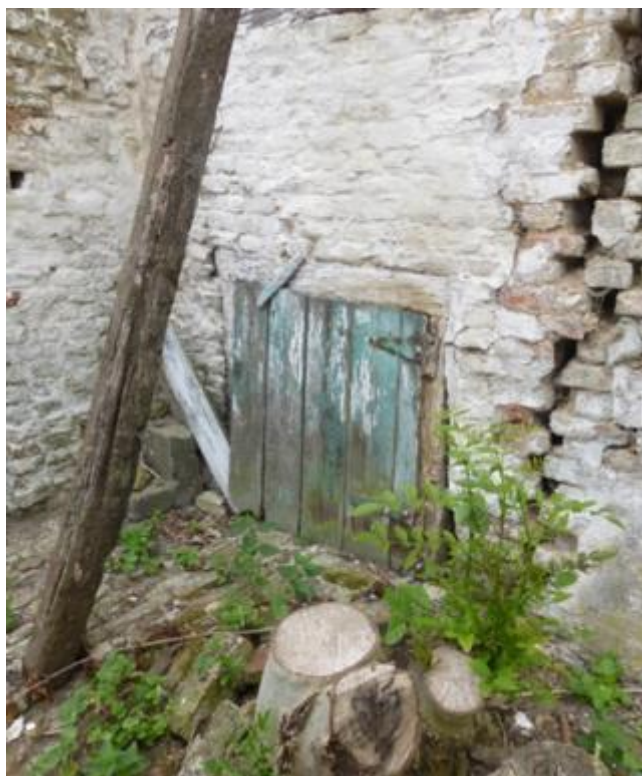
Foto 40: het lagere bakovengebouwtje waarin de oven ingebouwd is. Onderaan geeft een houten luikje toegang tot een droogruimte voor houtbussels: houten luik met smeedijzeren hang- en sluitwerk (kozijnconstructie) opslagruimte (plaatsbezoek Onroerend Erfgoed 23.06.2023).
