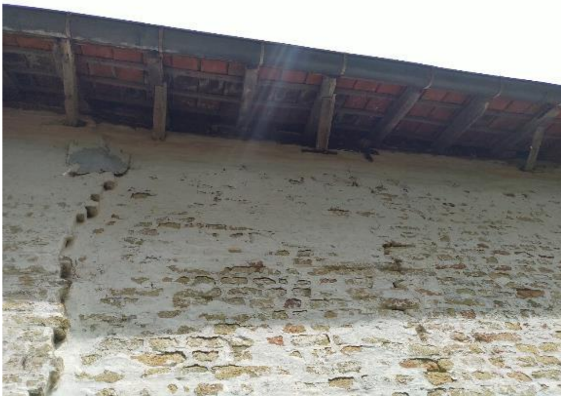
Foto 31: dakoverstek met houten klossen boven de gesloten achtergevel van het huis. Bouwspoor (plaatsbezoek Onroerend Erfgoed 23.06.2023).
