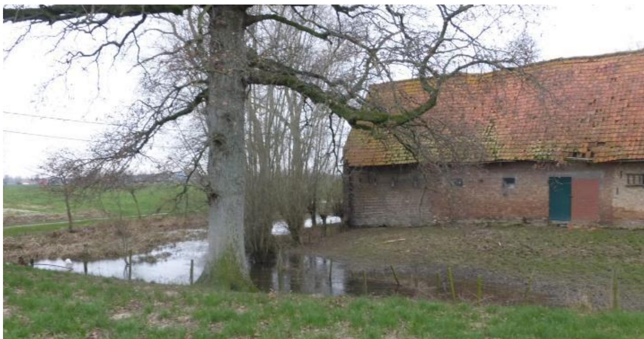
Foto 57: waarschijnlijk resulteren de langsgevels van de schuur, ook aan de achterzijde, uit de gefaseerde verstening van een vakwerkbouw, met diverse types metselwerk tot gevolg. Centraal geeft een deels dichtgemetselde muuropening nog de lage en smalle schuurpoort aan (plaatsbezoek Onroerend Erfgoed 17.01.2024).
