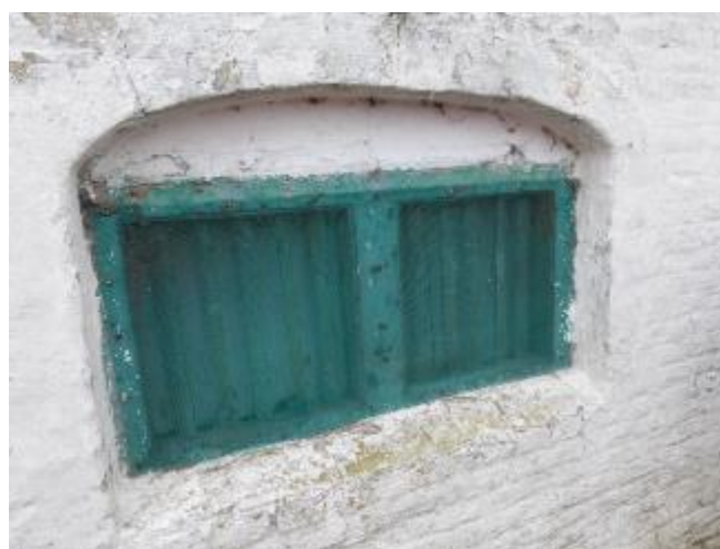
Foto 23: het rechthoekige keldervenster in de naar het neerhof gerichte gevel (hooghuis) is gevat in een steekboognis. Groengeschilderd enkel kozijnvenster met diefijzers en binnenluiken (plaatsbezoek Onroerend Erfgoed 17.01.2024).
