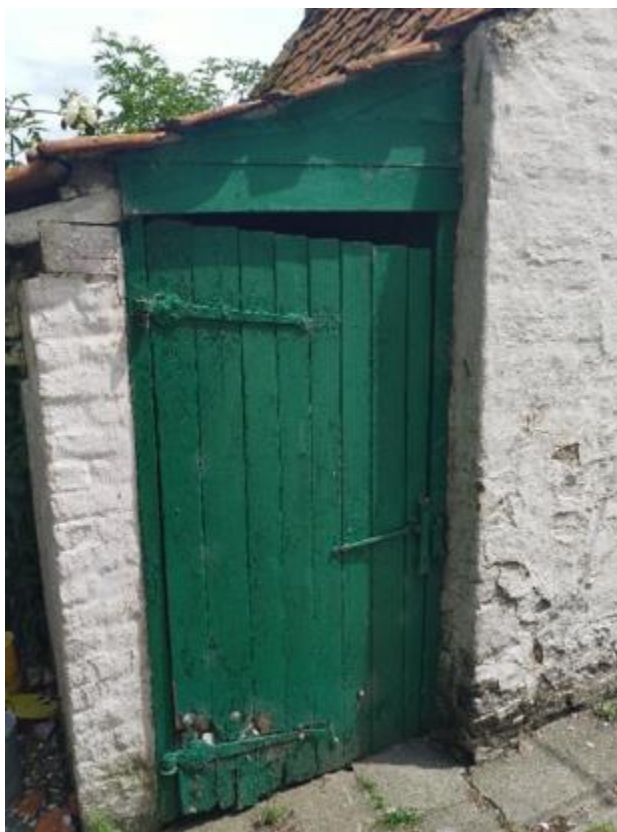
Foto 38: tegen het bakhuis leunt het buitentoilet onder lessenaarsdak aan. Groengeschilderde houten deur met smeedijzeren hang- en sluitwerk . Boven de deur, houten, horizontale beplanking (plaatsbezoek Onroerend Erfgoed 23.06.2023).
