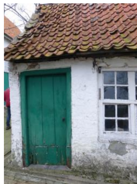
Foto 36: zijgevel van de werkruimte (bakhuis) met groengeschilderd houten laadvenster in het gevelveld (kozijnconstructie). Erfverharding van bakstenen op hun kant. Zicht op de walgracht (plaatsbezoek Onroerend Erfgoed 31.01.2024).
