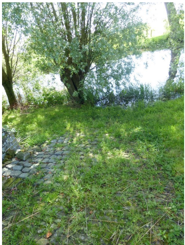
Foto's 69-70: de bestrating van bakstenen op hun kant langs de erfgevel gaat aan de zuidzijde over in een gekasseid wad dat afloopt naar de walgracht. Via dit gekasseide wad konden de koeien naar het water geleid worden om er te drinken (plaatsbezoek Onroerend Erfgoed 17.05.2024).
