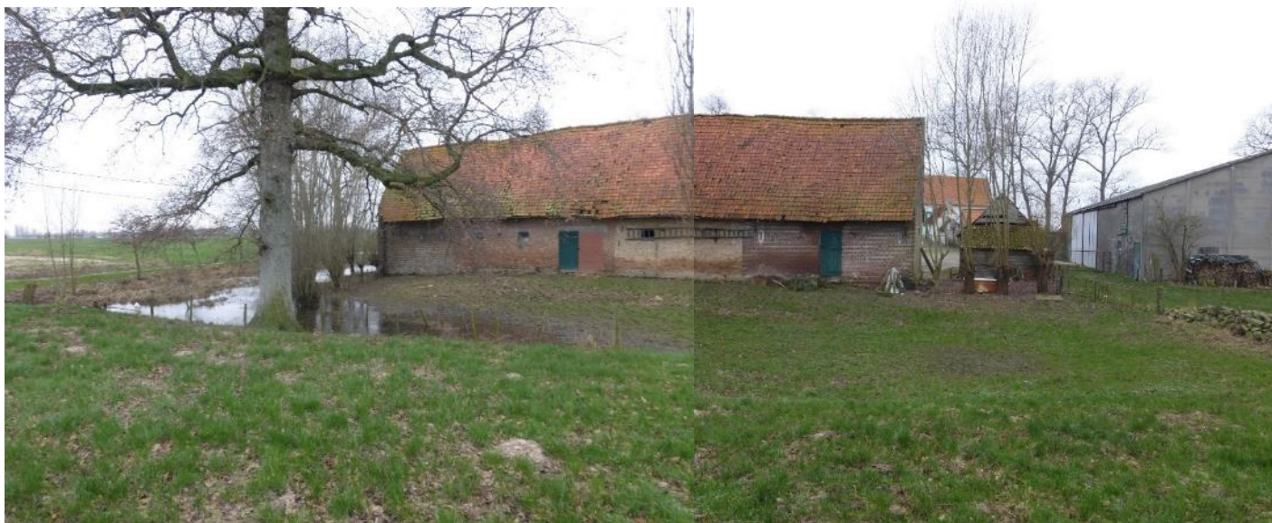
Foto's 55-56: de langsgevel aan de achterzijde van de dwarsschuur. Walgracht rond het neerhof, knotbomen en opgaande bomen. Links, aan de buitenoever van de walgracht, is een opgaande zomereik bewaard (plaatsbezoek Onroerend Erfgoed 17.01.2024).
