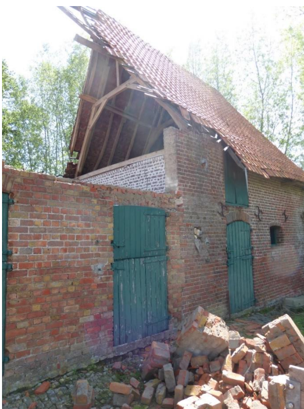
Foto 59: de dwarsschuur na de gedeeltelijke instorting van 3 april 2024. Vooral het middendeel ter hoogte van des schuurdoorrit liep veel schade op (plaatsbezoek Onroerend Erfgoed 17.05.2024). Foto 60: de dwarsschuur na de gedeeltelijke instorting van 3 april 2024. De traveeën met het oudste metselwerk, ook de zijgevels, blven bewaard (plaatsbezoek Onroerend Erfgoed 17.05.2024).
