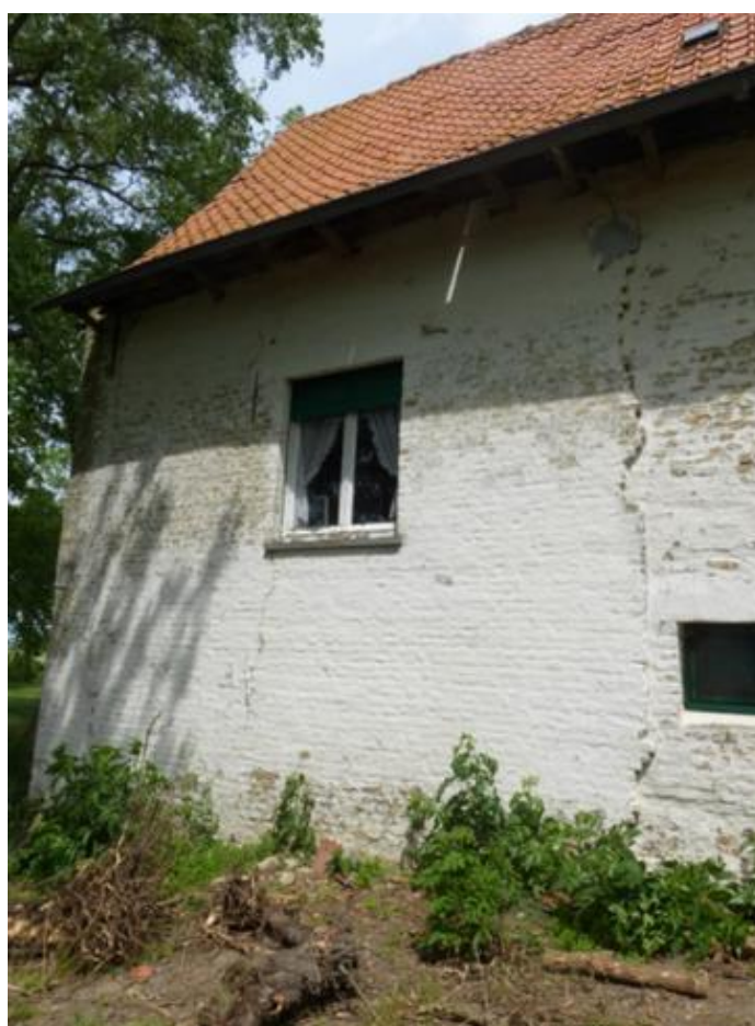
Foto 30: de gesloten achtergevel van het huis – gekarteld bouwspoor tussen opkamer en lager huisgedeelte. Het rechthoekige venster onder betonnen latei (zonder erfgoedwaarde) in de opkamer is recenter ingebracht (plaatsbezoek Onroerend Erfgoed 23.06.2023).
