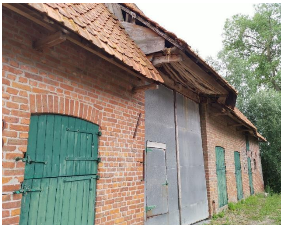
Foto's 45-46: de hoge schuurpoort onder een hogere dakoverstek, geflankeerd door telkens drie houten, tweeledige staldeuren. De zijkant van de hogere dakoverstek (poort) bewaart een plankenbeschiëting. Dakoverstek op houten klossen. De schuurpoort heeft een klein deurtje of klinket. Rechts: detail houten sluitsysteem van de poort en dakoverstek op houten klossen (plaatsbezoek Onroerend Erfgoed 23.06.2023).
