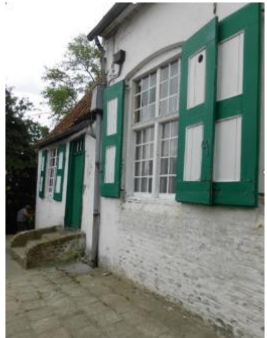
Foto 14: groen- en witgeschilderd houtwerk in de naar het neerhof gerichte gevel (hooghuis). Links van de deur zijn de rechthoekige vensters gevat in steekboognissen. De houten kruiskozijnen met kleine roedeverdeling en luiken gaan terug op de 18de eeuw. Boven de verlaagde opkamervensters zijn sporen van steekbogen bewaard (plaatsbezoek Onroerend Erfgoed 17.01.2024).
