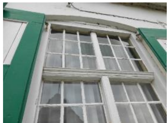
Foto 16: de voordeur met bovenlicht van het hooghuis is gevat in een houten, geprofileerd kozijn. Boven het geprofileerde kalf steekt het tweeledige bovenlicht met kleine roedeverdeling (2 vakken in de breedte, 3 in de hoogte) en diefijzers (plaatsbezoek Onroerend Erfgoed 23.06.2023).
