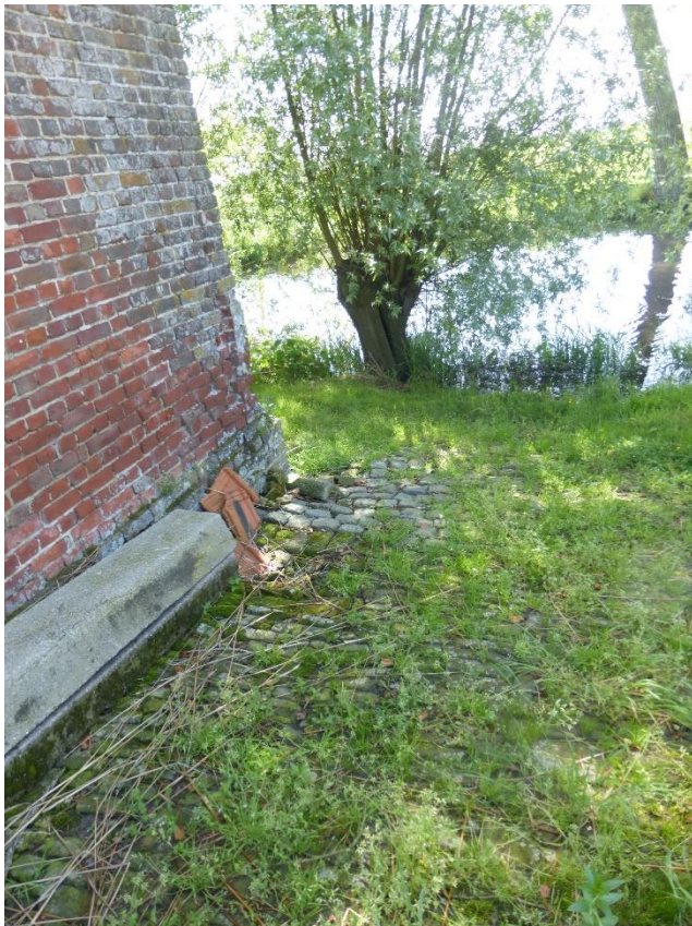
Foto's 69-70: de bestrating van bakstenen op hun kant langs de erfgevel gaat aan de zuidzijde over in een gekasseid wad dat afloopt naar de walgracht. Via dit gekasseide wad konden de koeien naar het water geleid worden om er te drinken (plaatsbezoek Onroerend Erfgoed 17.05.2024).
