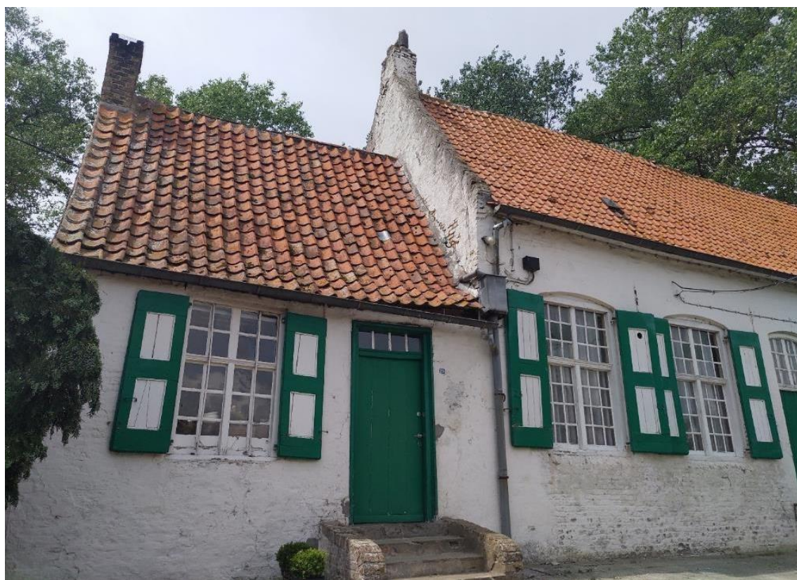
Foto 13: het witgeschilderd kruiskozijn met diefijzers en kleine roedeverdeling in de oostgevel van het laaghuis is voorzien van luiken. De deur met bovenlicht is gevat in een houten omlijsting (deurdorpel in kalksteen). De linker zijgevel van het hooghuis is afgewerkt met een aandak met vlechtingen en voorzien van een schoorsteen. Het zadeldak van het laaghuis is gedekt met rode Vlaamse pannen, dat van het hooghuis met recentere mechanische pannen (plaatsbezoek Onroerend Erfgoed 23.06.2023).
