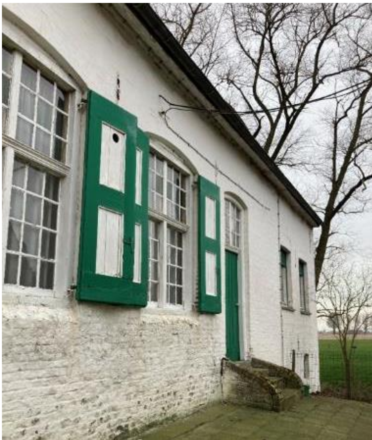
Foto 14: groen- en witgeschilderd houtwerk in de naar het neerhof gerichte gevel (hooghuis). Links van de deur zijn de rechthoekige vensters gevat in steekboognissen. De houten kruiskozijnen met kleine roedeverdeling en luiken gaan terug op de 18de eeuw. Boven de verlaagde opkamervensters zijn sporen van steekbogen bewaard (plaatsbezoek Onroerend Erfgoed 17.01.2024).
