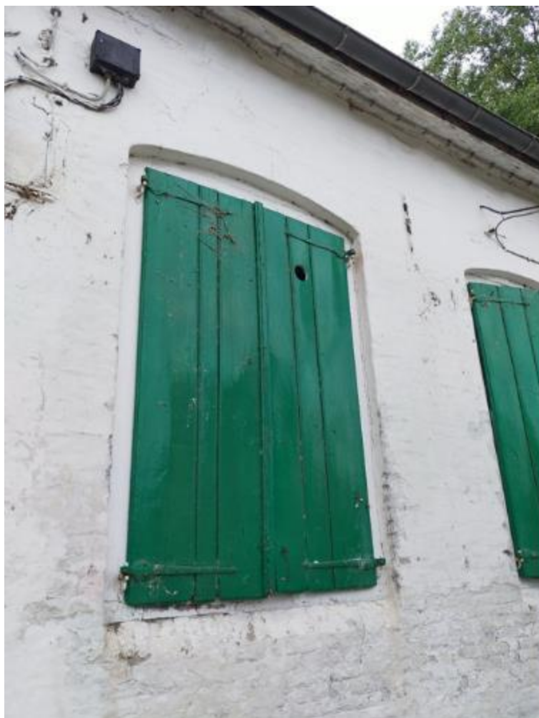
Foto 18: groengeschilderde, opgeklampte luiken met bewaard smeedijzeren hang- en sluitwerk in gesloten toestand (hooghuis). Kenmerkend voor kozijnconstructies steken de luikduimen in het houtwerk. In het rechter luik van het linker venster steekt bovenaan een rond spiongat (plaatsbezoek Onroerend Erfgoed 23.06.2023).
