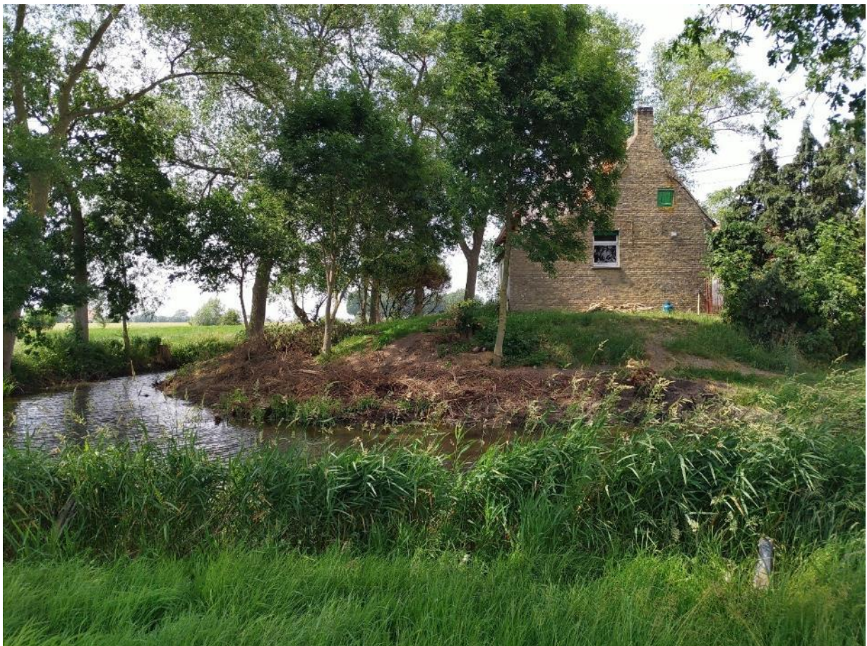
Foto 26: woning ingeplant op het omgrachte opperhof – vernieuwde zuidelijke zijgevel van het laaghuis (plaatsbezoek Onroerend Erfgoed 23.06.2023).
