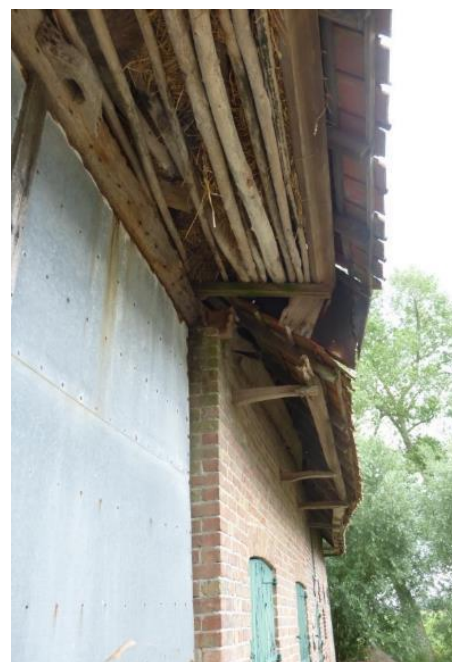
Foto's 45-46: de hoge schuurpoort onder een hogere dakoverstek, geflankeerd door telkens drie houten, tweeledige staldeuren. De zijkant van de hogere dakoverstek (poort) bewaart een plankenbeschiëting. Dakoverstek op houten klossen. De schuurpoort heeft een klein deurtje of klinket. Rechts: detail houten sluitsysteem van de poort en dakoverstek op houten klossen (plaatsbezoek Onroerend Erfgoed 23.06.2023).
