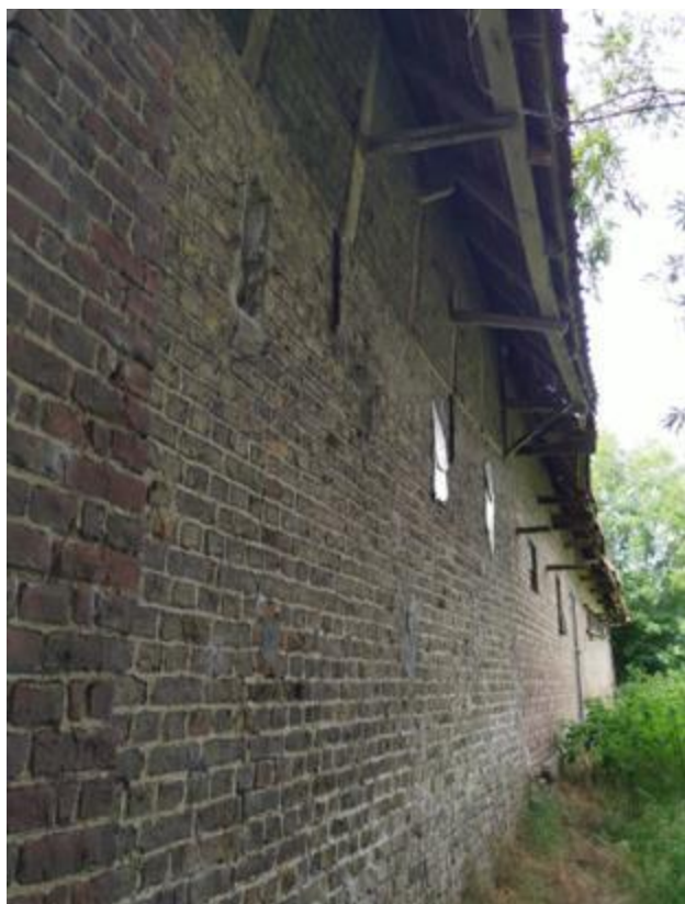
Foto 52: de linker (zuidelijke) traveeën van de achtergevel zijn gemetseld in recentere, gele baksteen en opengewerkt met asemgaten. Onder de dakoverstek is stijl- en regelwerk (vakwerk) met invulling van baksteen bewaard. De klossen van de dakoverstek sluiten aan op de stijlen (plaatsbezoek Onroerend Erfgoed 23.06.2023).
