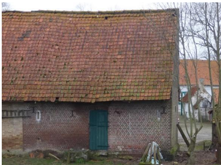
Foto 52: de linker (zuidelijke) traveeën van de achtergevel zijn gemetseld in recentere, gele baksteen en opengewerkt met asemgaten. Onder de dakoverstek is stijl- en regelwerk (vakwerk) met invulling van baksteen bewaard. De klossen van de dakoverstek sluiten aan op de stijlen (plaatsbezoek Onroerend Erfgoed 23.06.2023).
