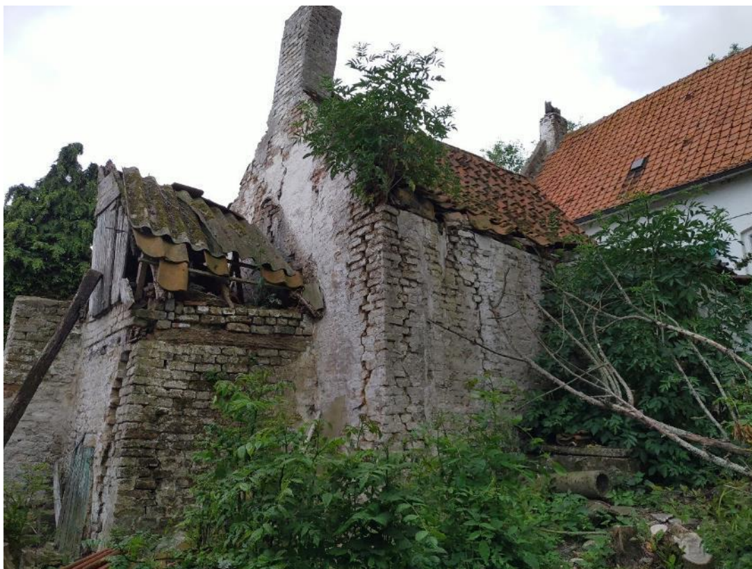
Foto 42: bakhuis van het tweeledige type (noordzijde) – links de hogere werkruimte – rechts het lagere bakovengebouwtje, op smallere plattegrond – zadeldaken met rode Vlaamse pannen (plaatsbezoek Onroerend Erfgoed 23.06.2023).
