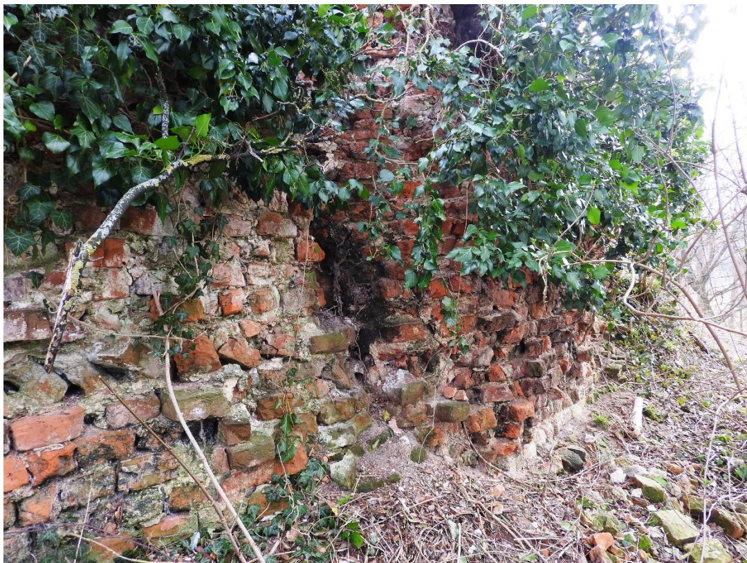
Foto 25: overblijfsel van de keermuur rond de donjon, met metselwerk in bakstenen van groot formaat (20 februari 2019).
