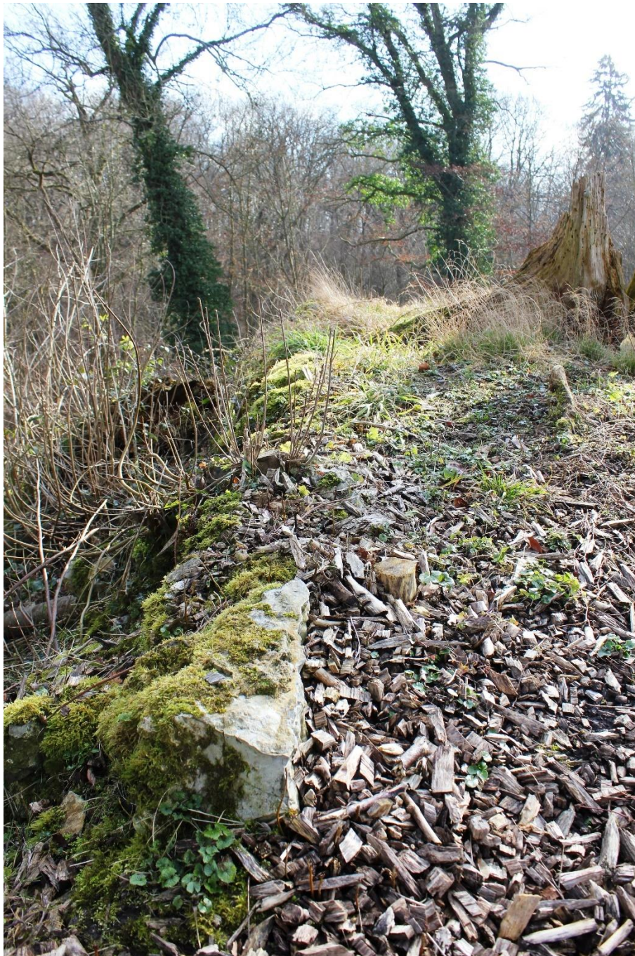
Foto 9: overblijfsel van metselwerk in natuursteen bovenop de aarden omwalling van het neerhof (15 februari 2022).
