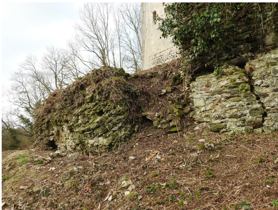
Foto 24: overblijfsel van de keermuur rond de donjon (20 februari 2019).
