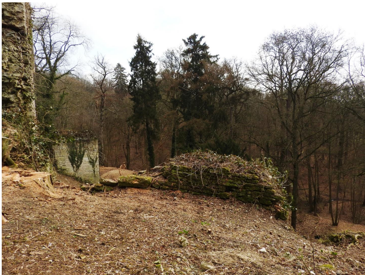
Foto 23: overblijfsel van de keermuur rond de donjon (20 februari 2019).
