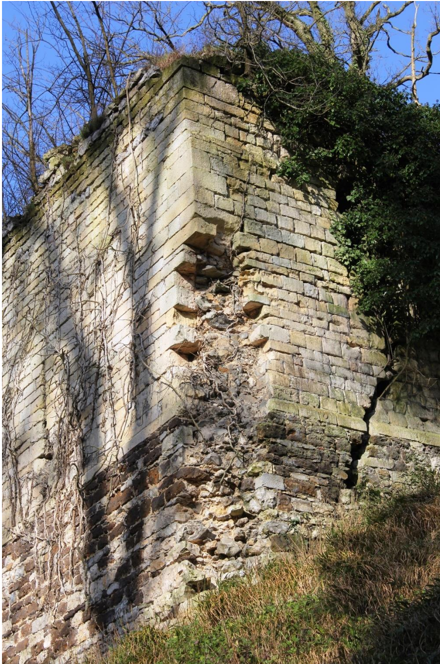
Foto 12: oostelijke hoek van de toren (extra muros zijde) in de omheining van het neerhof (15 februari 2022).
