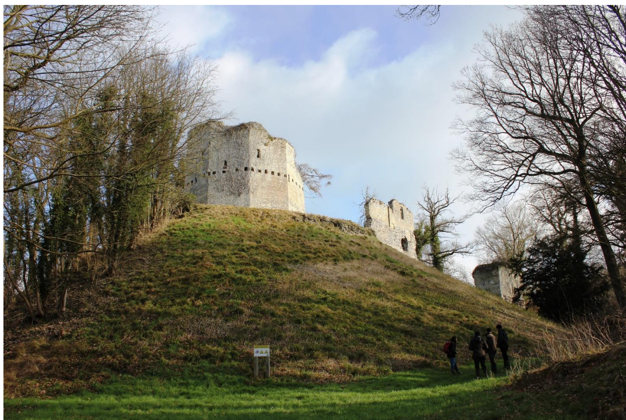
Foto 2: zicht op de ruïne van de burcht van Kolmont (15 februari 2022). Van links naar rechts: donjon, het overblijfsel van de zogenaamde "love" en de toren van de omheiningsmuur rond het neerhof.
