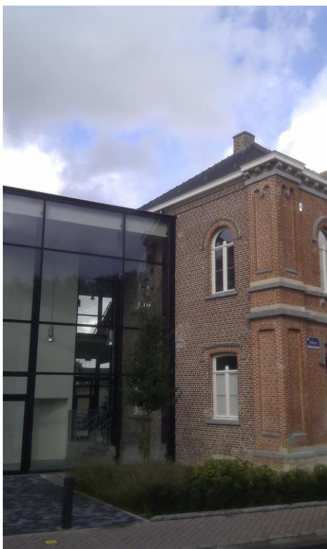
Foto 3: algemeen zicht op de nieuwe aanbouw.
