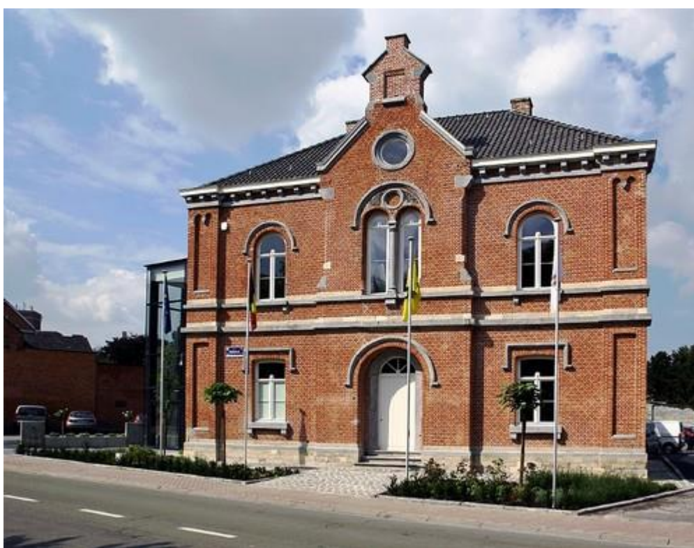
Foto 2: algemeen zicht op de onderwijzerswoning.
