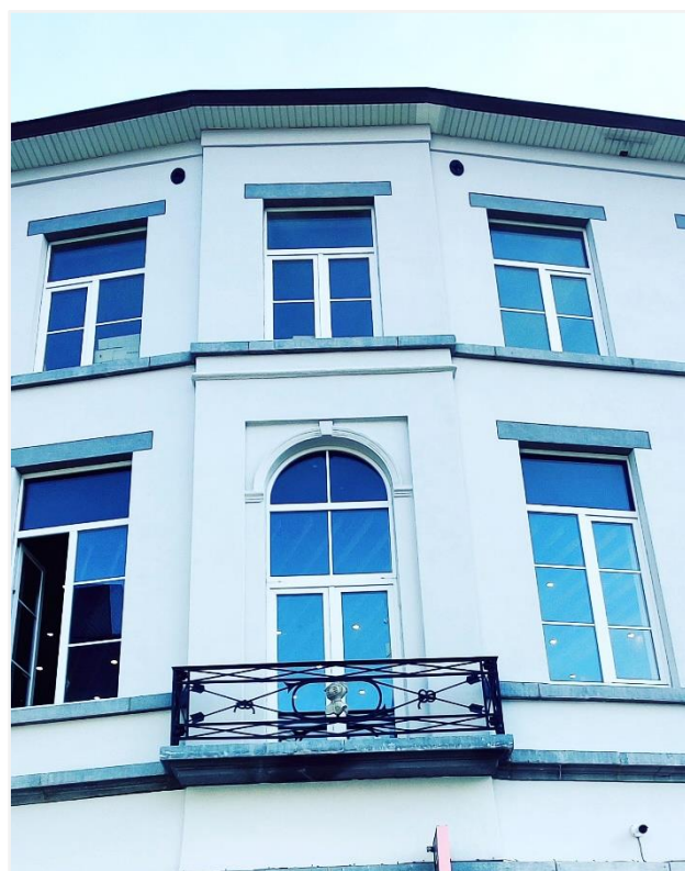
Foto 3: voorgevel: detail risalietvormend travee
