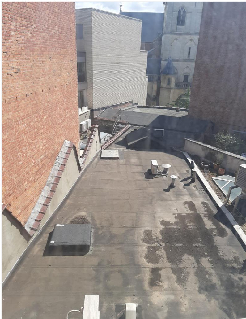
Foto 5: begane grond: uitbreiding achteraan over het ganze perceel
