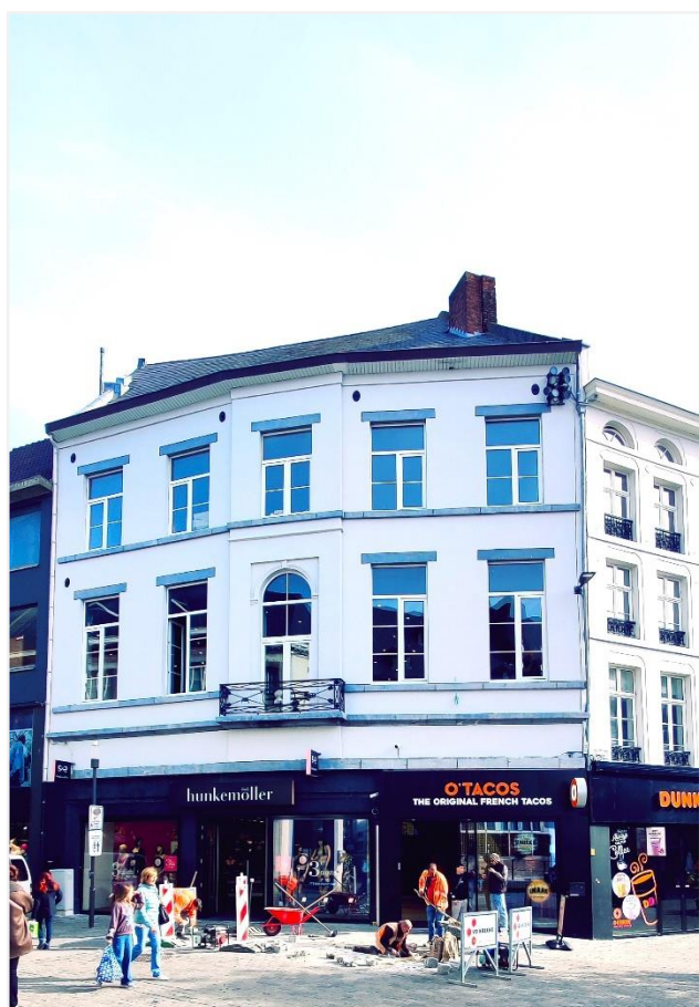
Foto 2: voorgevel: verbouwde begane grond en bewaarde verdiepingen in empirestijl
