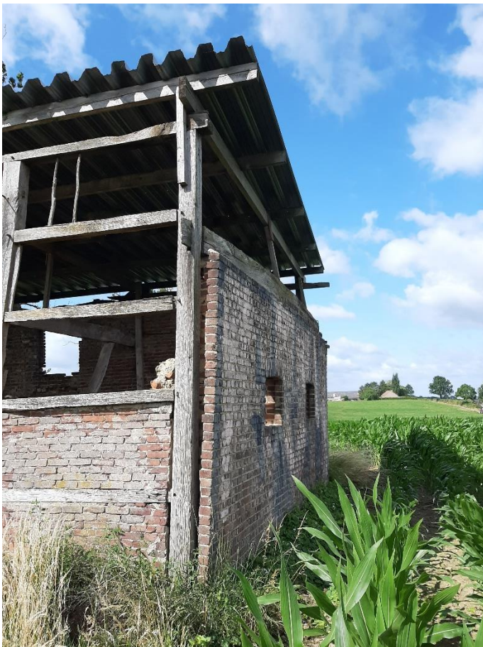
Foto 6: Detail van de noordgevel van de vakwerkschuur.
