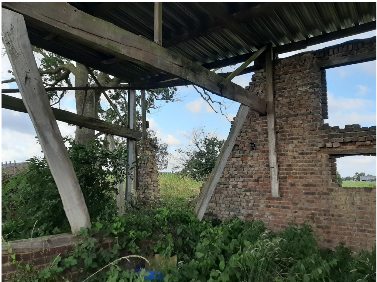
Foto 10: Interieur van de vakwerkschuur.
