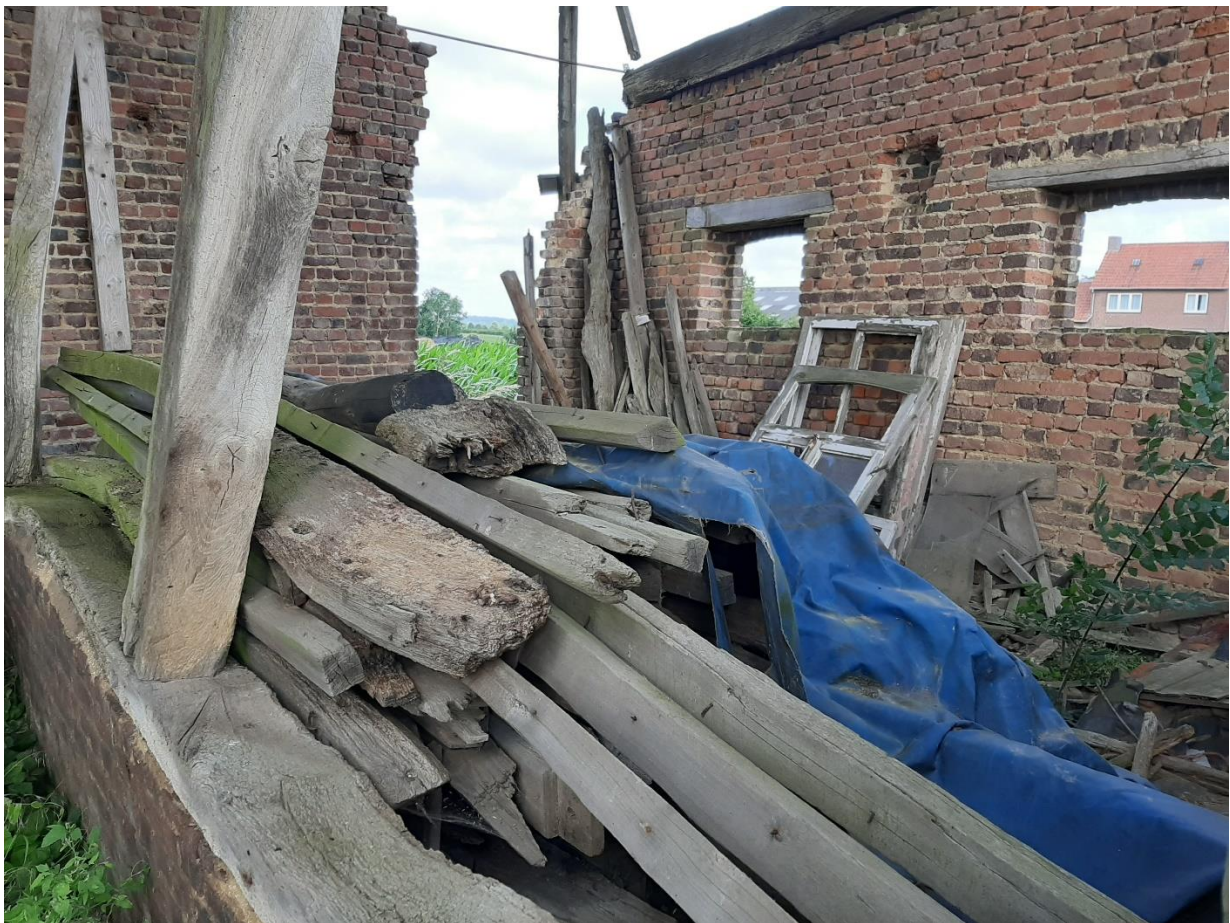
Foto 8: Interieur van de vakwerkschuur.
