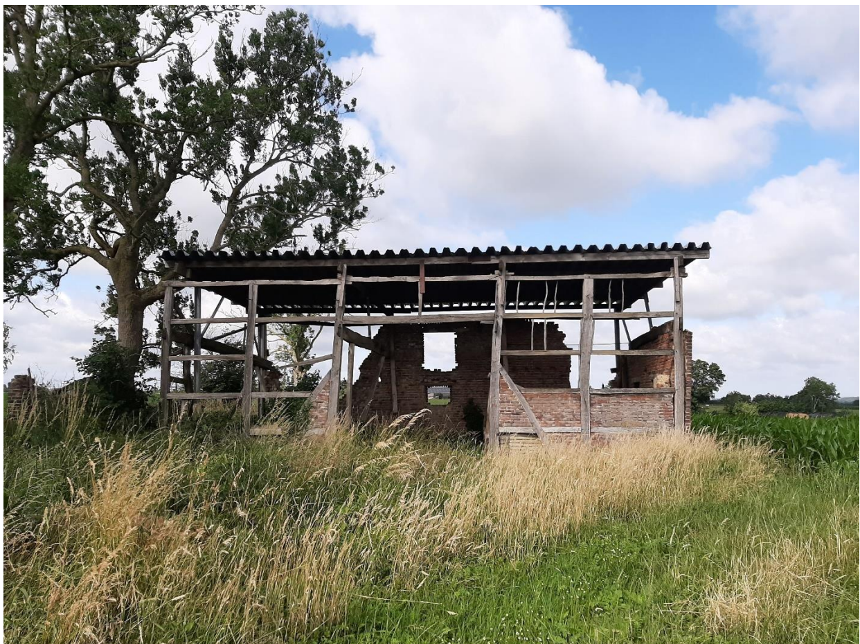
Foto 2: De oostgevel van de vakwerkschuur.
