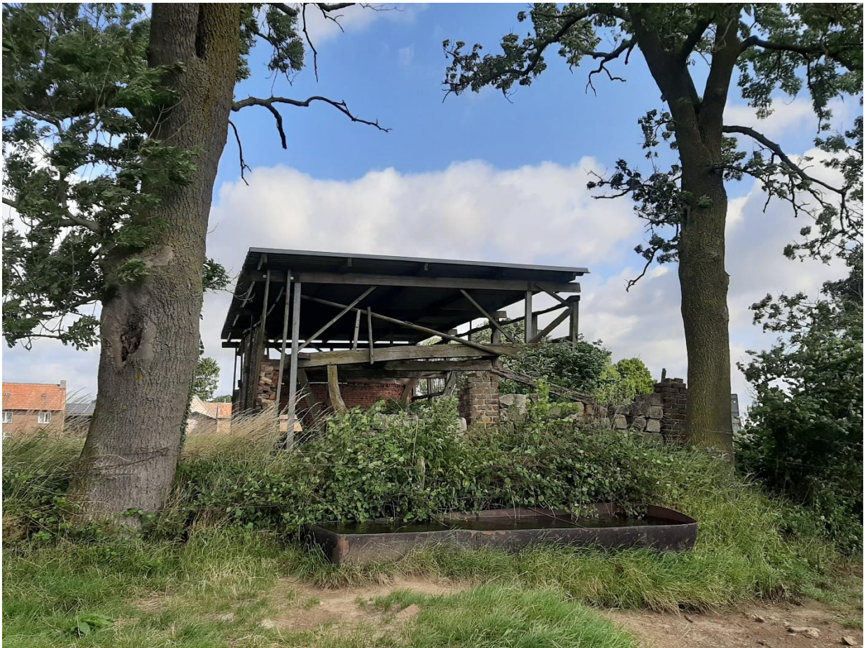
Foto 3: De zuidgevel van de vakwerkschuur.
