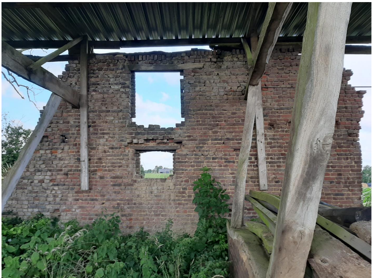
Foto 9: Interieur van de vakwerkschuur.
