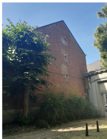
Foto 8: Stadswoning, nummer 65, noordelijke zijgevel – rond zoldervenster in geveltop.
