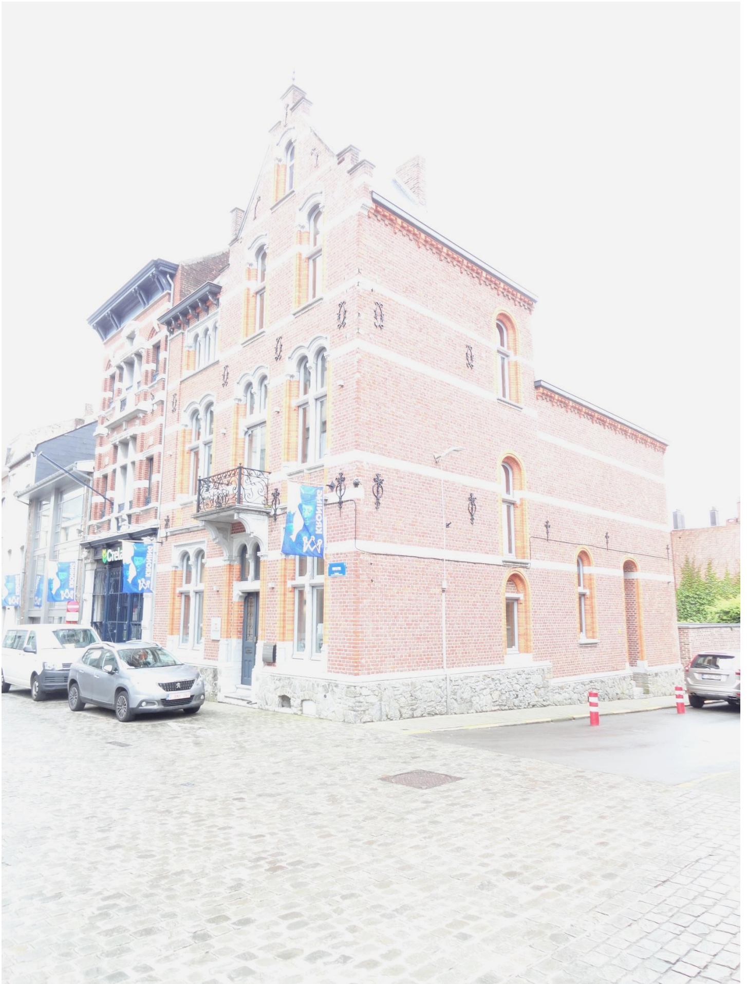
Foto 1: Het huis Piepelpoel 13, op de hoek van de Piepelpoel en de Corversstraat.
