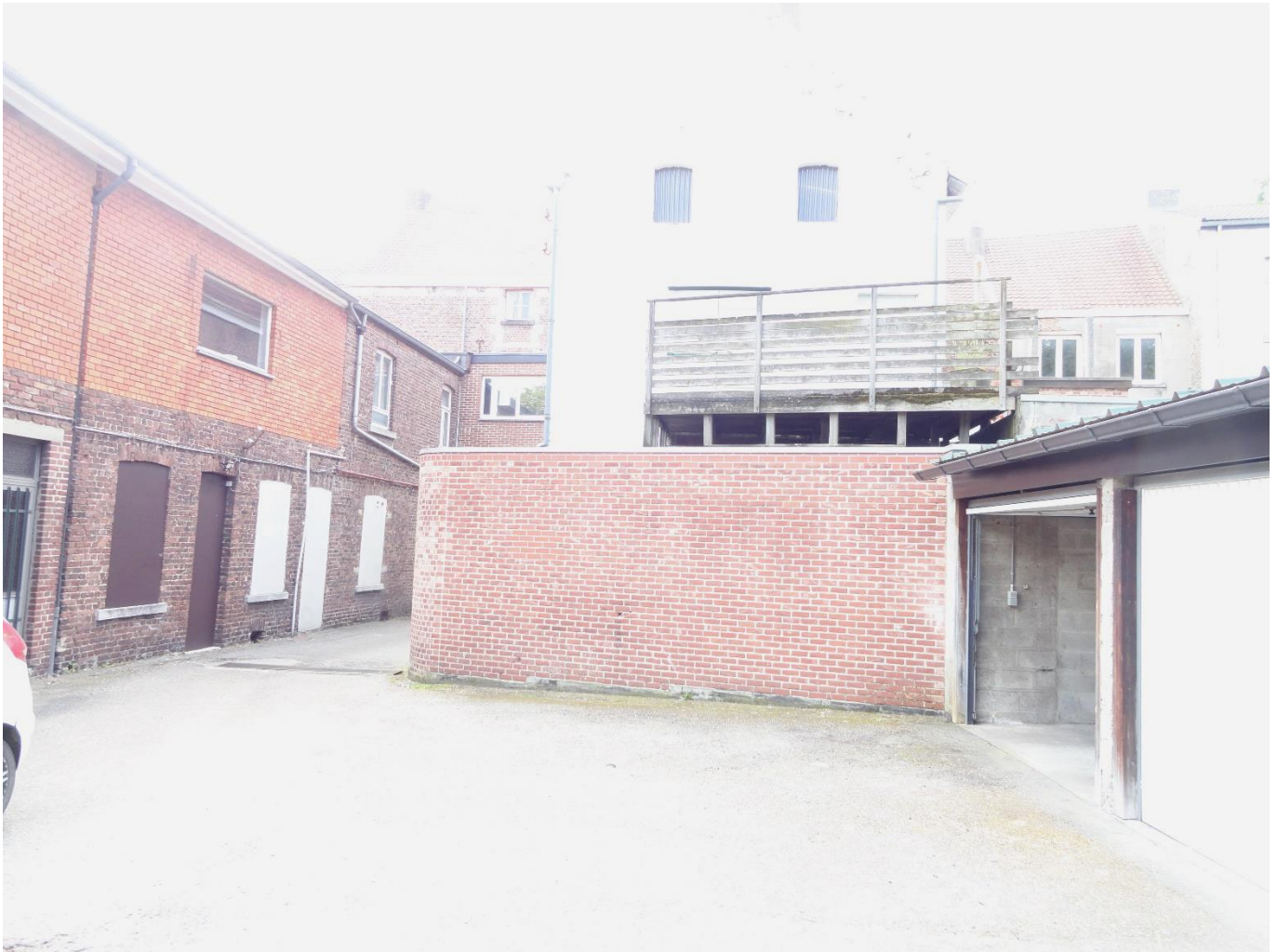
De achterzijde van het pand Maastrichterstraat 94-96 (25 mei 2023)
