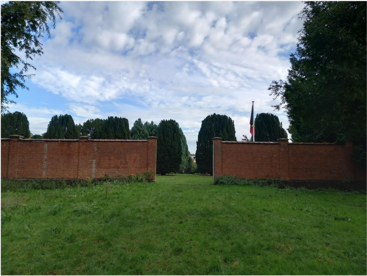
Foto 16: Scheidingsmuur tussen begraafplaats en Rosendaelpark. Detail vanuit het Rosendaelpark naar de begraafplaats. Gedenksteen bevindt zich ter hoogte van vlaggenmast.
