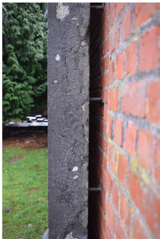
Foto 9: Heropgerichte gedenksteen. Detail verankeringssysteem.
