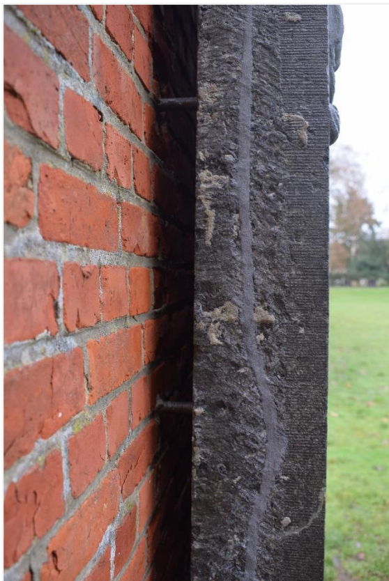
Foto 10: Heropgerichte gedenksteen. Detail verankeringssysteem
