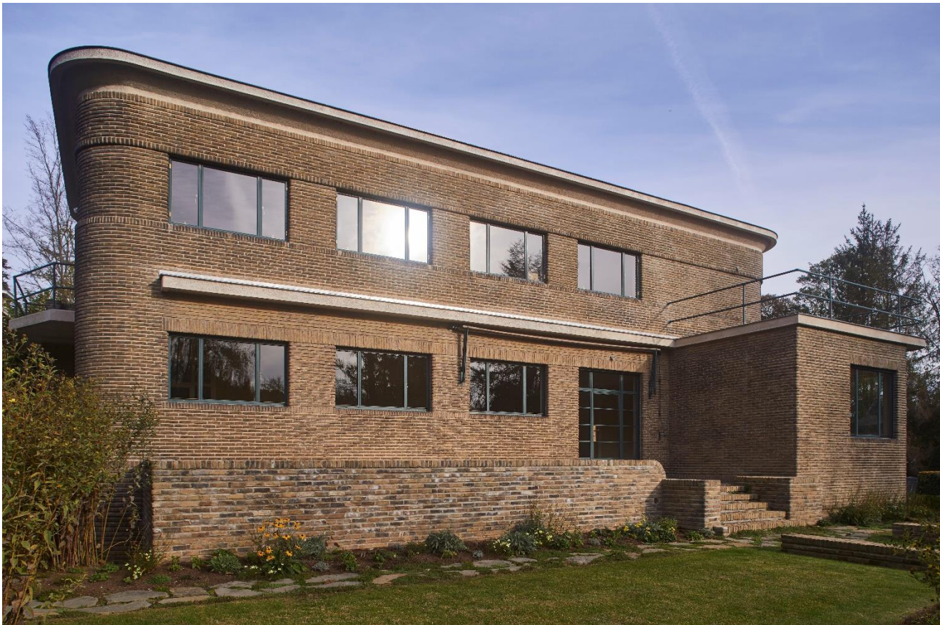
Foto 2: Zuidwestgevel met terras en tuintrap.
