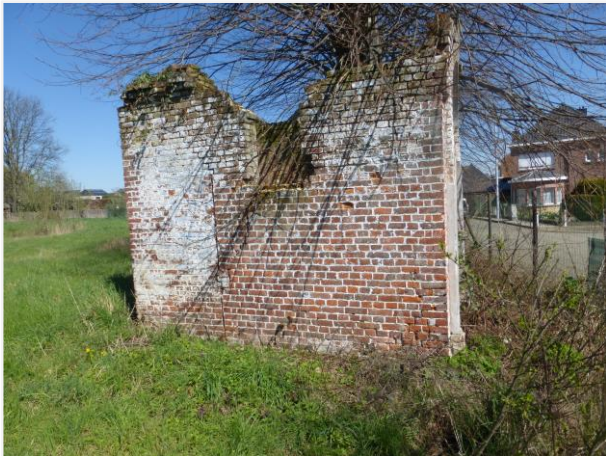
Foto 3: De westelijk zijgevel van de kapel.
