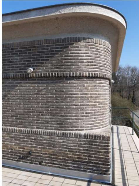
Foto 10: afgeronde hoek op de 1ste verdieping, zuidgevel.
