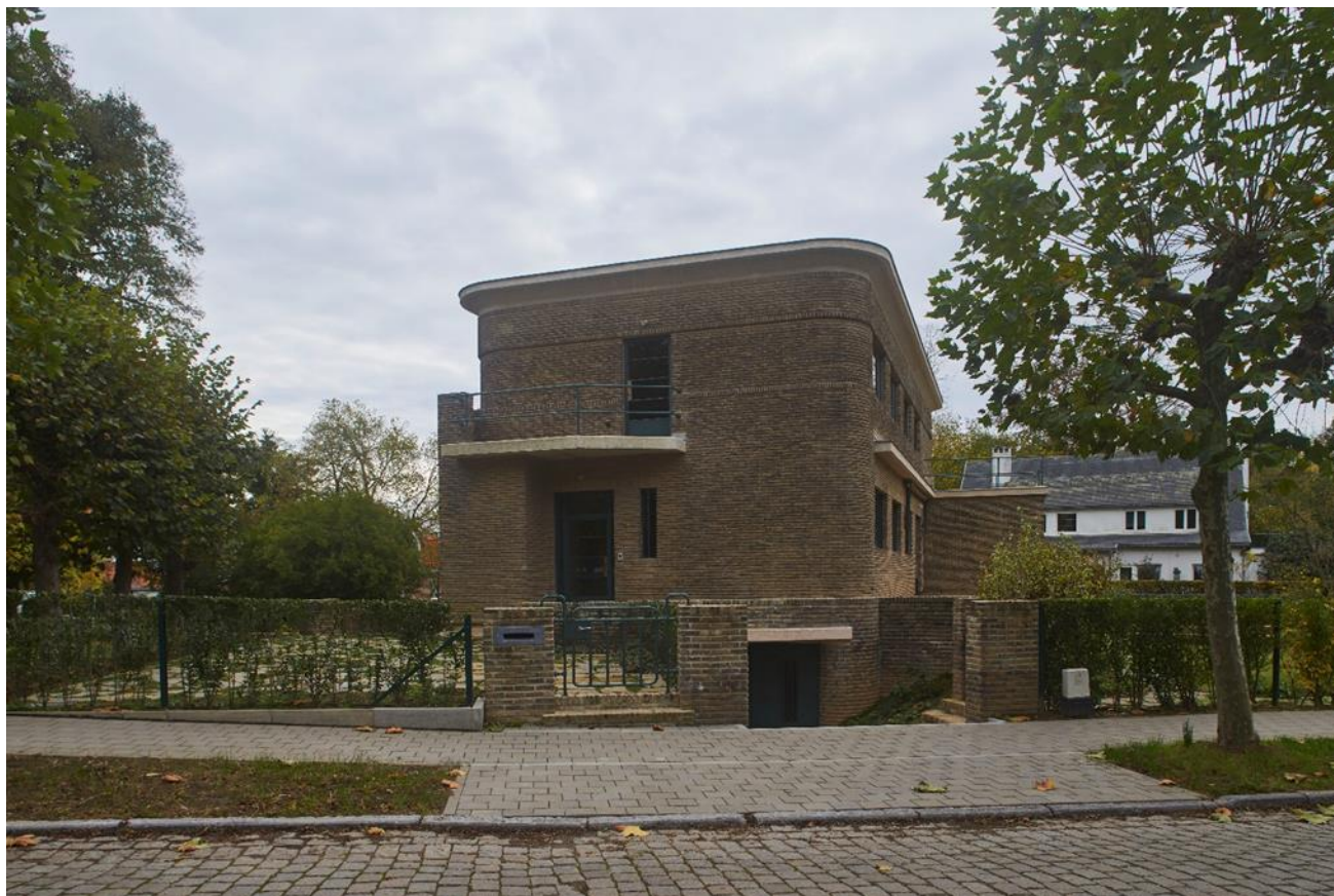
Foto 1: Noordwestgevel met toegangszone afgesloten door een hek in buismetaal tussen bakstenen hekpijlers.
