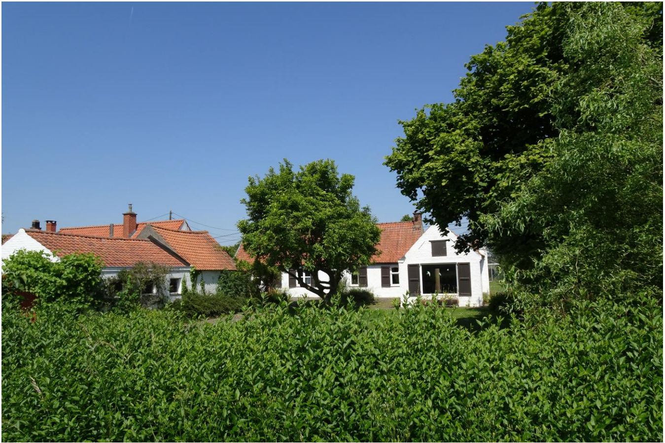
Foto 20: voormalige landarbeiderswoning in het meerskantgehucht Huiwede, Meersstraat 6
