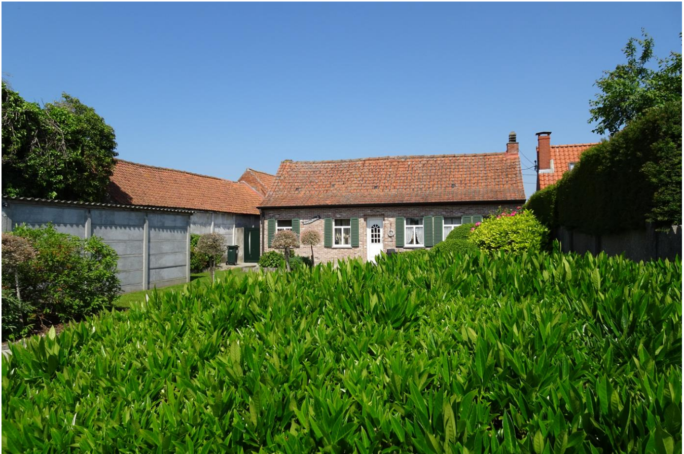
Foto 18: voormalige landarbeiderswoning in het meerskantgehucht Huiwede, Meersstraat 4
