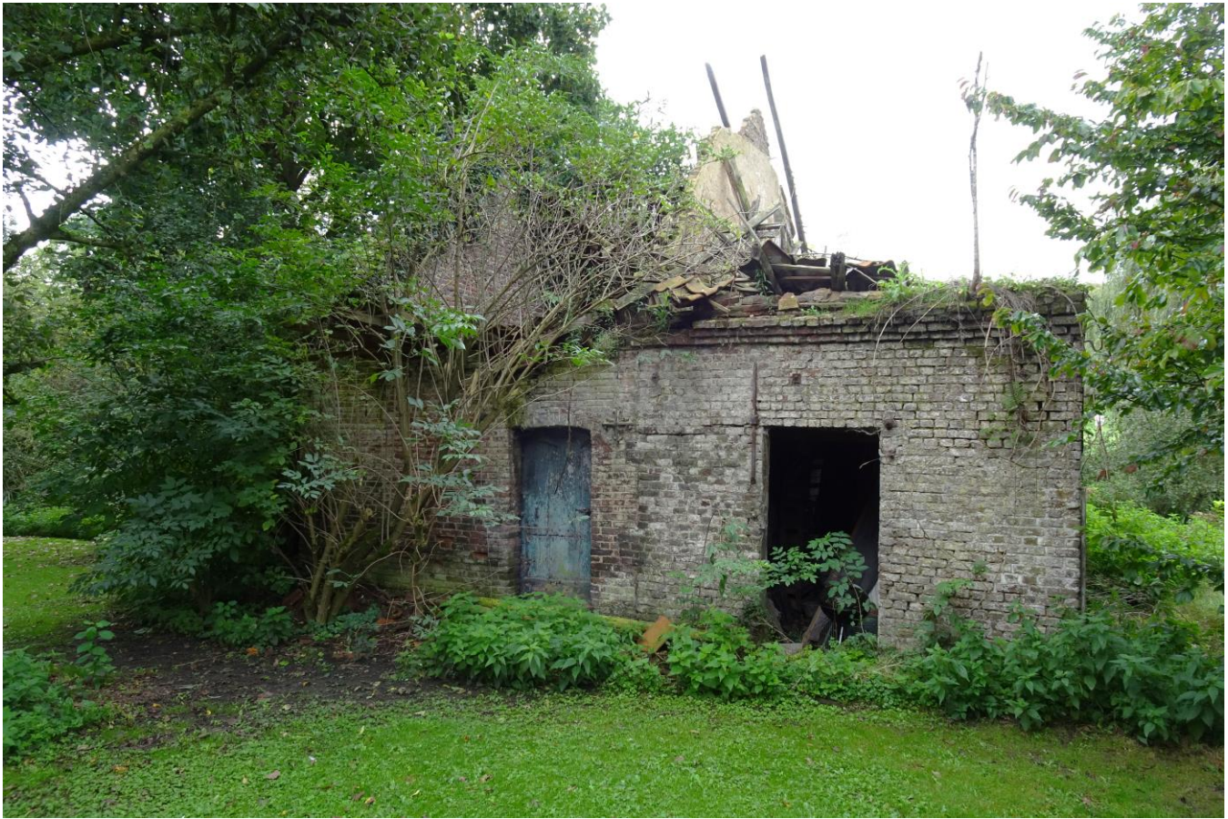
Foto 14: bakhuys bij verbouwde hoeve, Muurstraat 10
