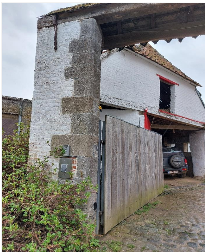
Foto 34: Verankerde brede rechthoekige toegangspoort met hardstenen negblokken, houten latei en onder ezelsrug (kunstleien).
