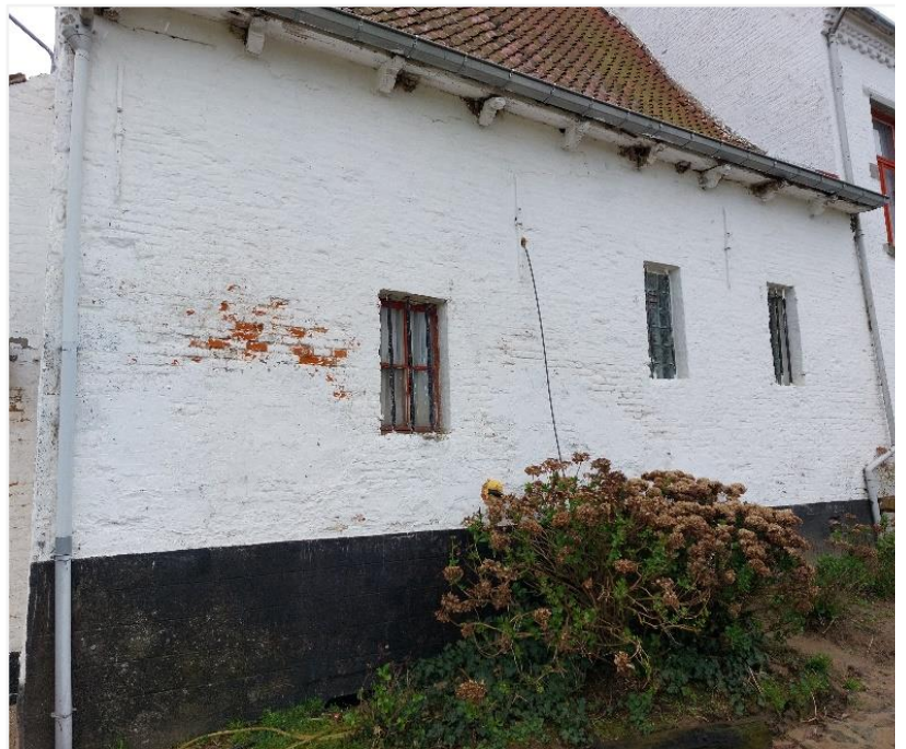
Foto 28: Onderkelderd en verankerd 17de-eeuws boerenhuis, met aflijnende dakvoet met klosjes- tongewelfde kelder onder links venster. .
