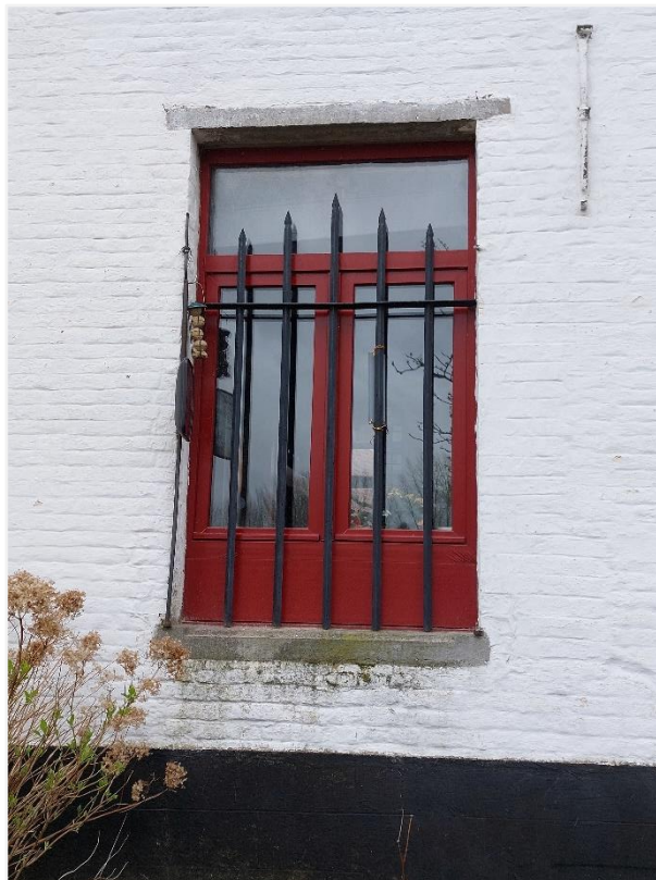
Foto 23: Getralied venster op de begane grond met blauw hardstenen boven- en onderdorpel in gevelvlak – muuranker .
