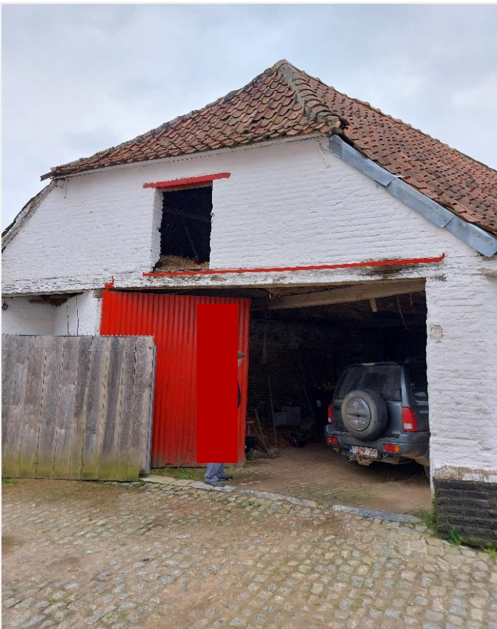
Foto 81: Vroegere remise – in 20ste eeuw omgevormd tot stallen en thans terug in gebruik als remise – noordelijke gevel – brede poort onder gevelbrede houten latei en centraal diltvenster.
