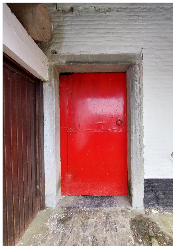
Foto 71: Stalvleugel van 1805 – zuidelijke deur gevat in hardstenen omlijsting met dezelfde profilering als de gedateerde noordelijke deur- voorheen toegang tot paardenstallen..
