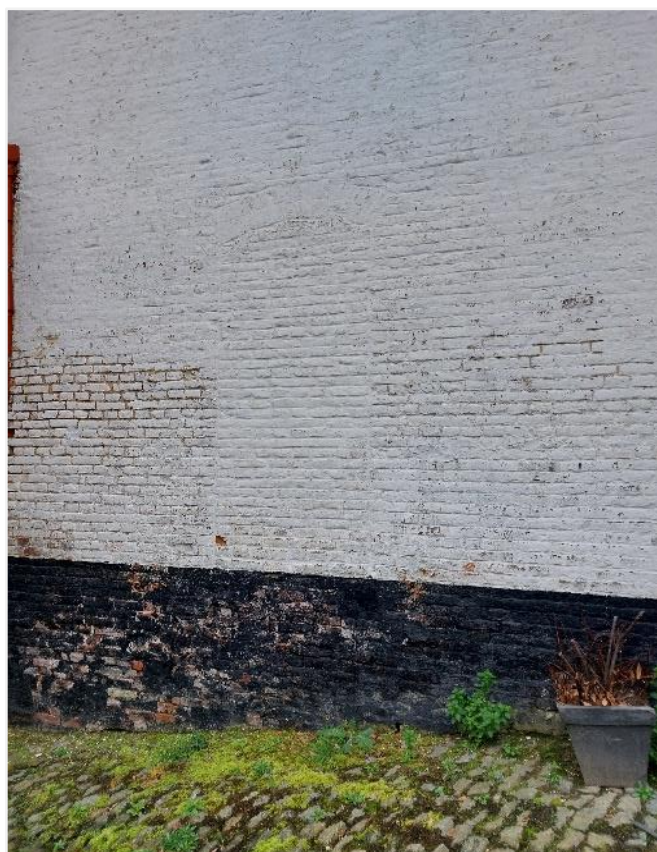
Foto 76: Langsschuur – bewaarde erfgevel met gedichte deur/poort.
