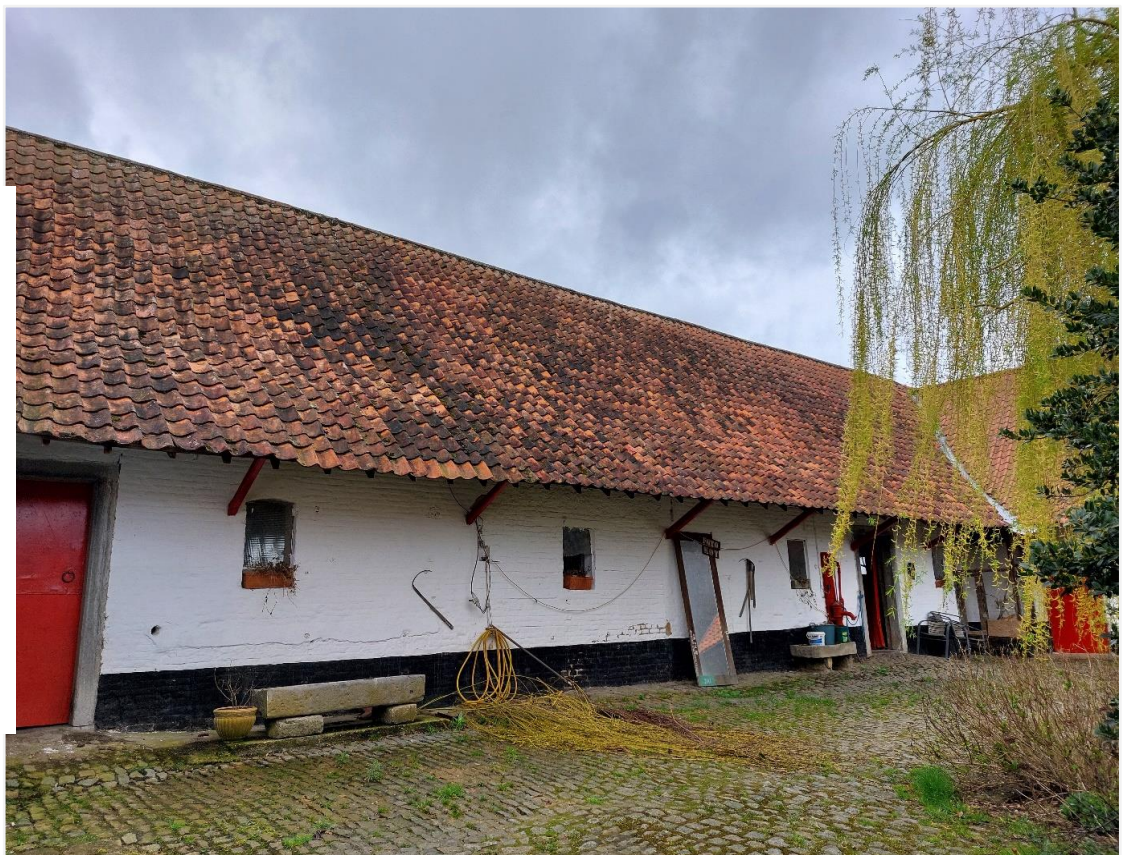
Foto 73: Stalvleugel van 1805 aan westzijde van erf – snijgend pannen zadeldak met ver overstekend dakoversterk.
