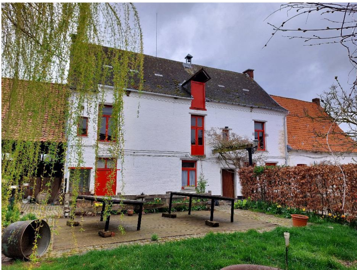
Foto 50: 18de-eeuws boerenburgerhuis van twee bouwlagen met onregelmatige muuropeningen aan erfzijde – centraal laaddakvenster met ver overstekend zadeldak onder dakklokje – beplante vroegere mestvaalt (vooraan)..
