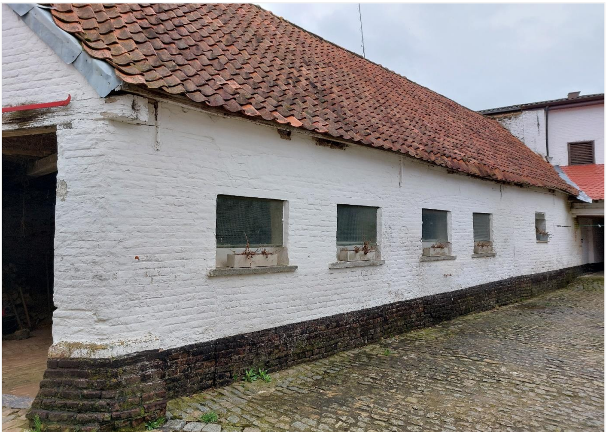
Foto 80: Vroegere remise onder afgewolfd zadeldak (ten oosten) – rechthoekige vensters geplaatst bij de omvorming van de remise tot stal in de 2de helft van de 20ste eeuw – thans terug gebruikt als remise – uitwaaiierende getrapte gevelhoek als versteviging van de muur die ook fungeerde als schampconstructie om schade ten gevolge van aanrijdingen te vermijden..
