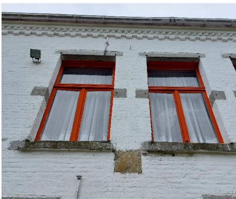
Foto 20: Bovenverdieping deurtravee met datumsteen tussen twee gekoppelde bovenvensters met blauw hardstenen onder- en bovendorpel en hoekblokken – luikogen en bovenaan aflijnende baksteenfries.
