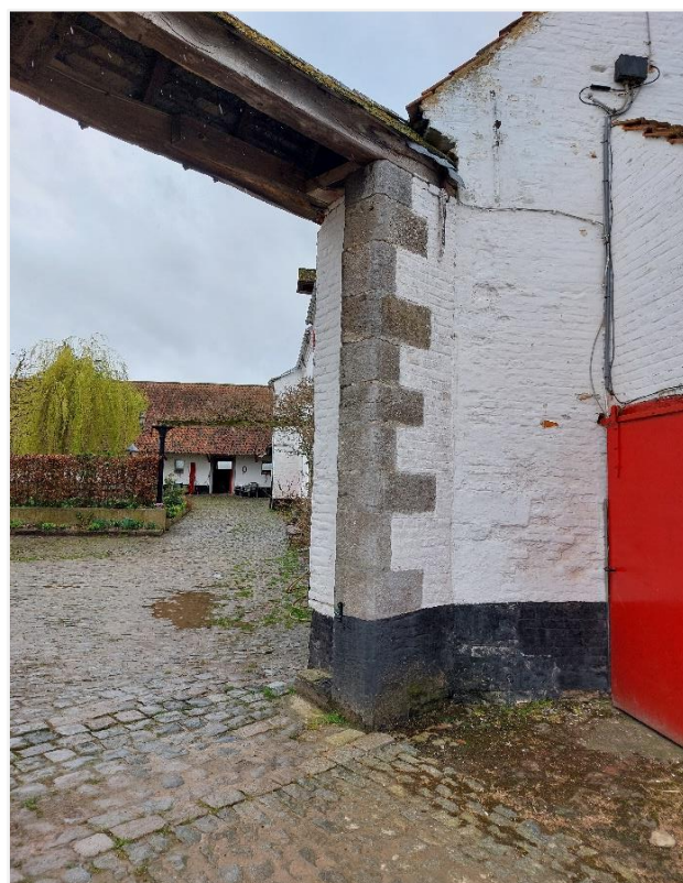
Foto 35: Verankerde brede rechthoekige toegangspoort met hardstenen negblokken, houten latei en onder ezelsrug (kunstleien).
