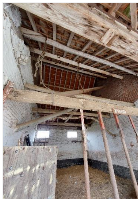
Foto 62: Vroegere remise van de heer, in tweede helft 20ste eeuw omgevormd tot stal – detail spanten..
