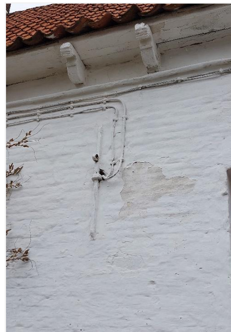
Foto 49: 17de-eeuws boerenhuis – muuranker met krul en detail dakoverstek met houten klosjes.
