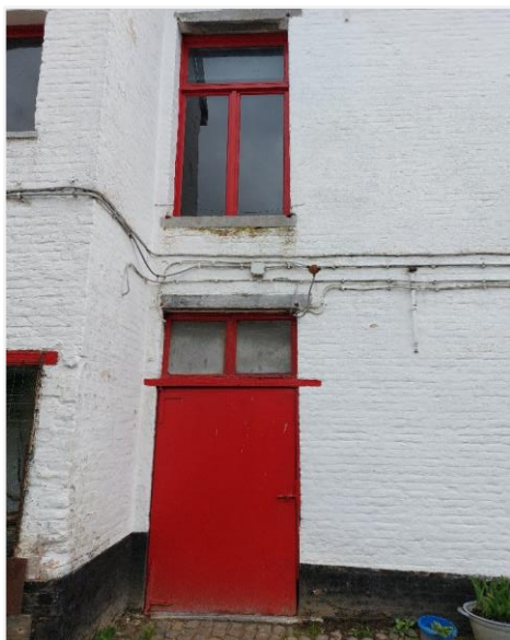
Foto 55: Voorlaatste travee met deur en bovenvenster.
