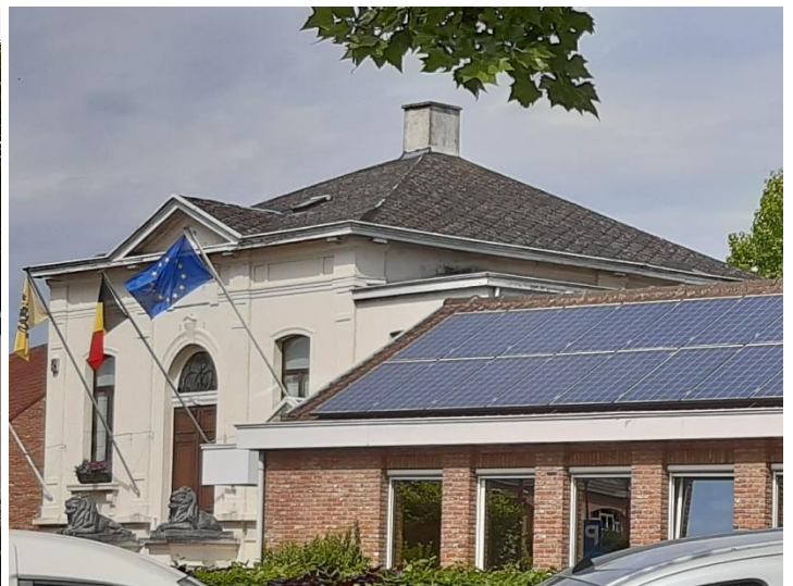
Foto 4: voorgevel en bedaking.
