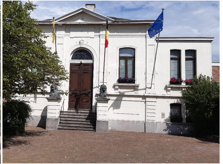
Foto 2: voorgevel en oostelijke aanbouw.
