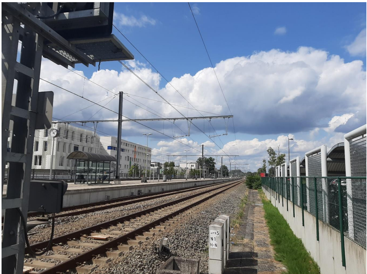
Foto 6 - Zicht op het spoor in noordelijke richting waar de wisselhendel verdween (opname 5 juli 2023) (© Onroerend Erfgoed – Annelien Sys).
