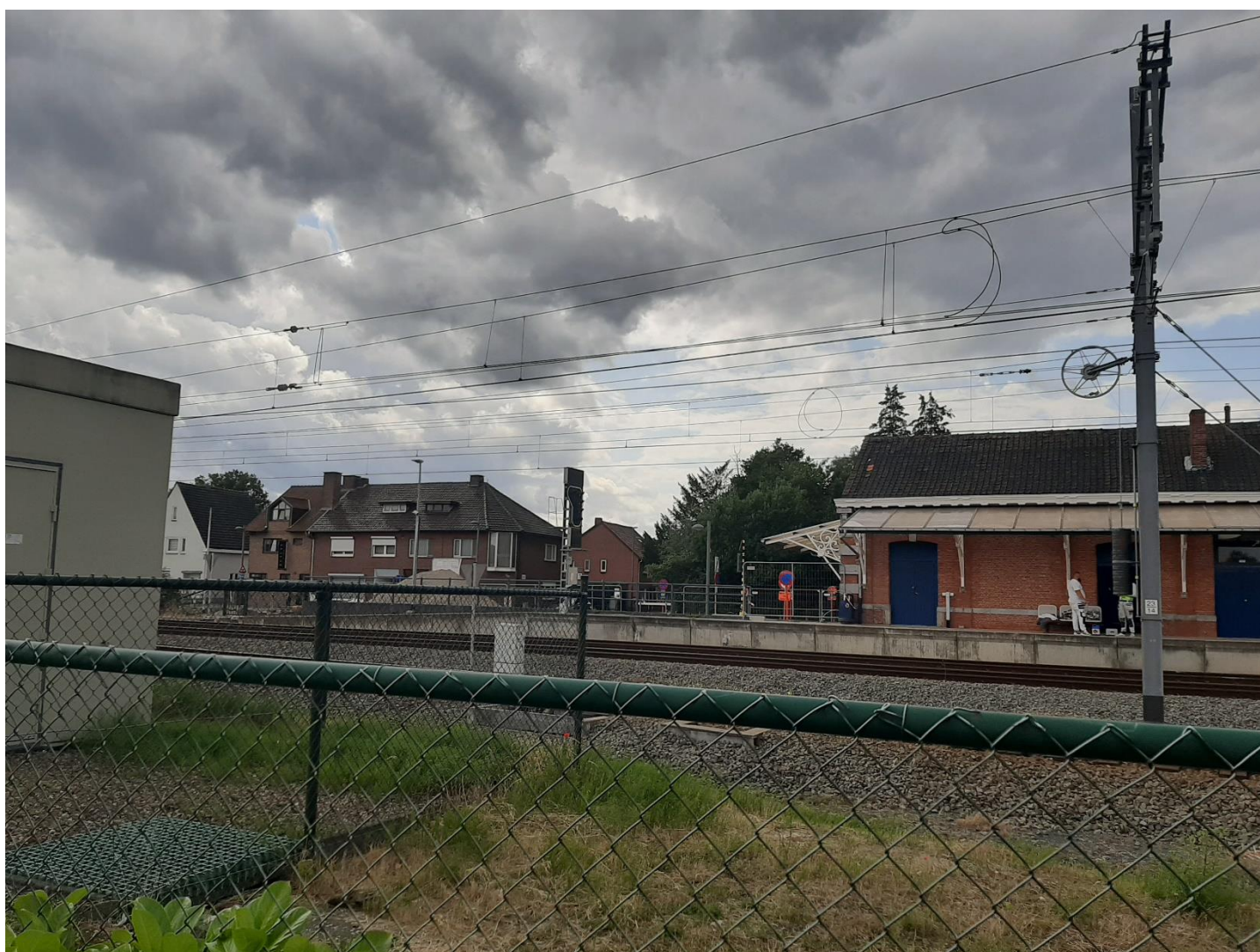
Foto 2 – Zicht vanuit het oosten op de ruimte rechts van het stationsgebouw waar tot 1995 de lampisterie stond (opname 5 juli 2023) (© Onroerend Erfgoed – Annelien Sys).
