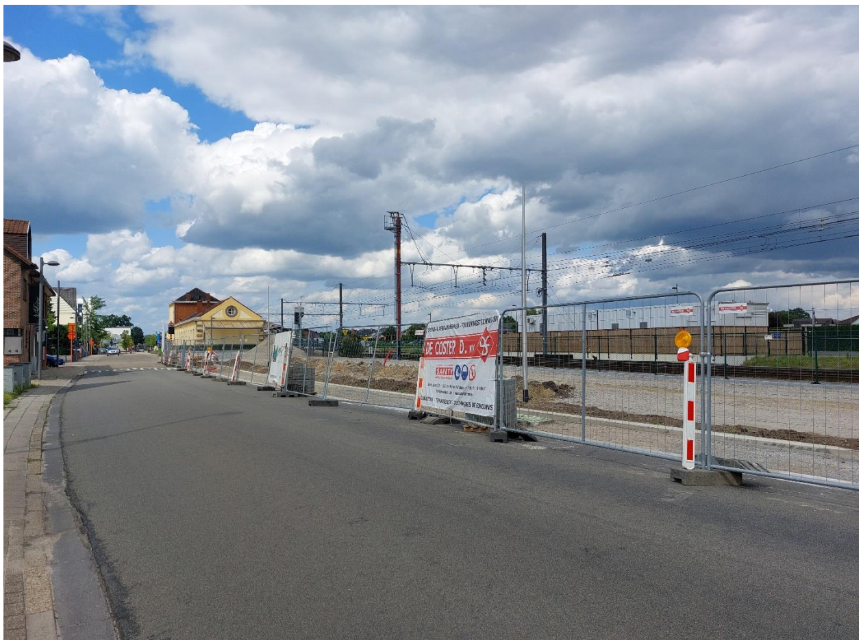
Foto 4 – Zicht vanuit het zuidwesten op de ruimte rechts van het stationsgebouw waar tot 1995 de lampisterie stond (opname 5 juli 2023) (© Onroerend Erfgoed – Katrien Verwinnen).
