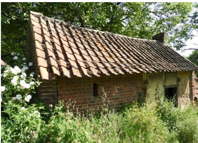
Foto 44: Zicht op de zuidelijke langsgevel van het bakhuis en het ten westen aansluitende stalletje onder doorgetrokken zadeldak. De roodbakstenen muur van het stalletje is hier enkel opengewerkt door een asemgat. Rechts sluit de zuidelijke vakwerkwand van het bakhuis aan (14 juni 2023)
