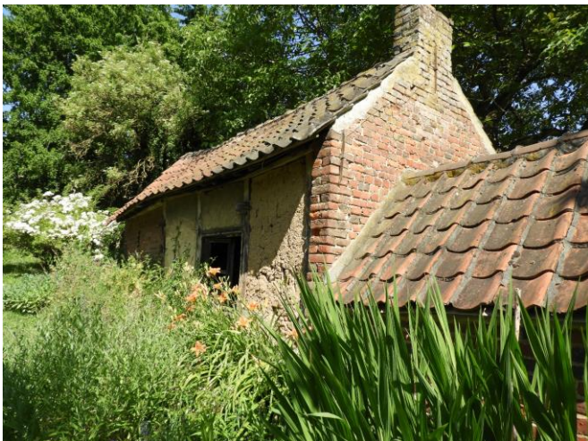
Foto 45: Zicht op de zuidelijke langsgevel van het bakhuis en het ten westen aansluitende stalletje onder doorgetrokken zadeldak. De vakwerkwanden van de langsgevels van het bakhuis en de oostelijke zijgevel van het bakhuis met aanleunend lager bakovengebouwtje (donkerrode, handgevormde baksteen) behoren tot de oorspronkelijke constructie. De verankerde zijgevel loopt op in de schoorsteen op de nok van het bakhuis (14 juni 2023)
