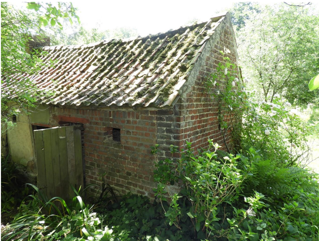
Foto 42: Zicht op de noordgevel (met houten deur en stalvenster) en de blinde zijgevel van het varkensstalletje. Dit stalletje steekt onder een doorgetrokken zadeldak. De recentere bakstenen langsegevels van dit stalletje vervangen vermoedelijk vroegere vakwerkwanden. Naast de rode mechanische baksteen wijzen daar ook de kopse afboording en de verticale, niet-gehechte bouwnaad met de smalle zijanten van de zijgevel op. De zijgevel in donkerrode, handgevormde baksteen behoort tot de oorspronkelijke constructie (14 juni 2023)
