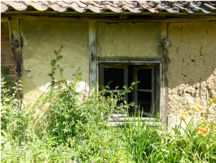
Foto 46: Zicht op de zuidelijke langsgevel van het bakhuis. Stijl- en regelwerk met leemvullingen. De houten balk- of muurankers in de stijlen geven in het exterieur aan waar zich binnenin ankerbalken bevinden. Deze gevel van het bakhuis is centraal opengewerkt door een houten venster (14 juni 2023)
