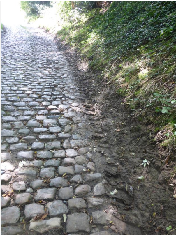
Foto 7: Spoorvorming in de holle weg ten gevolge van het landbouwverkeer.
