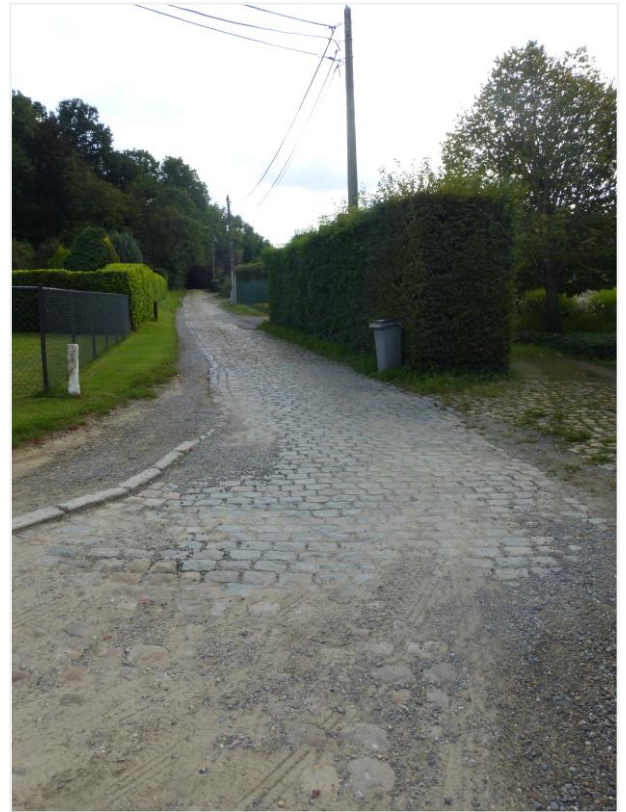
Foto 10: De aanzet van de kasseiweg bij de Meerstraat werd heraangelegd met porfier kasseien.
