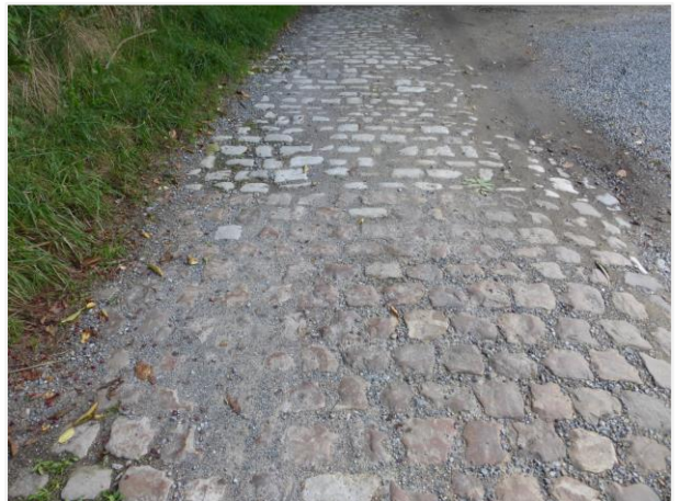
Foto 8: Overgang van Gobertange naar Tiense kwartsiet ter hoogte van de bebouwing aansluitend bij de Meerstraat.
