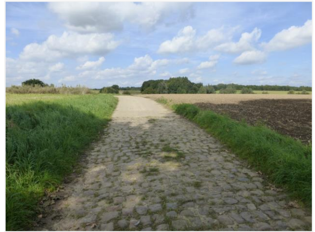
Foto 10: Op het plateau gaat de kasseiweg over in een betonverharding.
