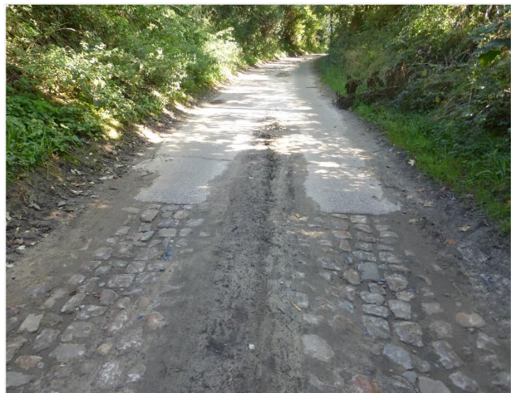
Foto 8: De kasseiweg gaat over in een betonverharding.
