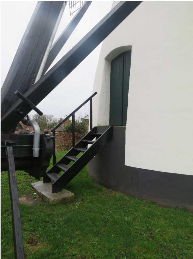
Foto 50 - Ezaartmolen. Oostelijke toegang tot meelzolder © 2024 Onroerend Erfgoed.
