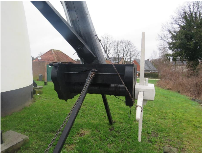
Foto 52 - Ezaartmolen. Uitwendig kruierwerk © 2024 Onroerend Erfgoed.
