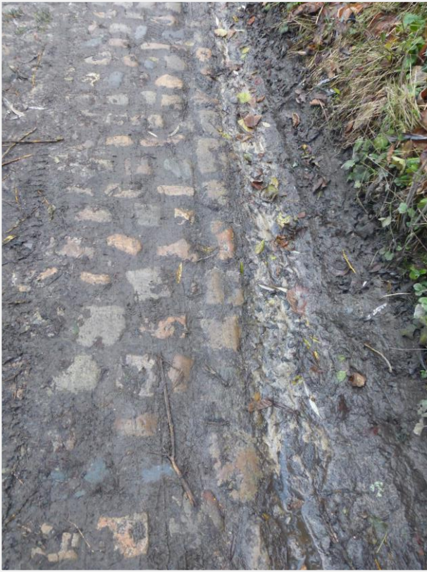
Foto 5: In de lengte geplaatste kasseien in Tiense kwartsiet als boordstenen.
