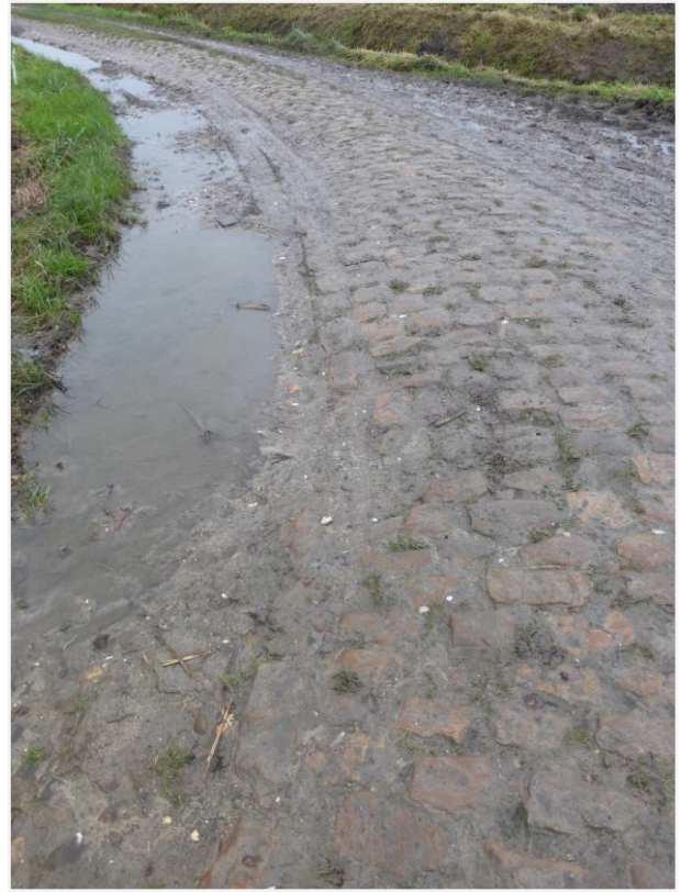
Foto 6: Spoorvorming in de bocht ten gevolge van het landbouwverkeer.
