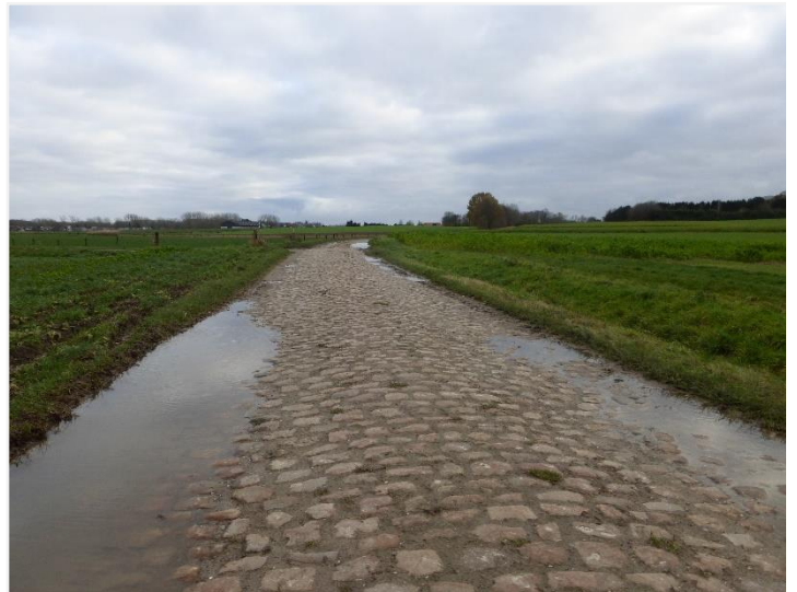
Foto 8: De kasseiweg met licht tonrond profiel en spoorvorming.
