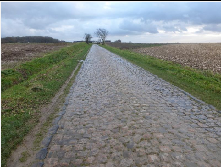
Foto 3: Boordstenen in Petit Granit en parallelle langsrachten.
