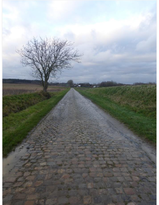
Foto 6: Recht wegtracé dat doorloopt over de grens met Wallonië.
