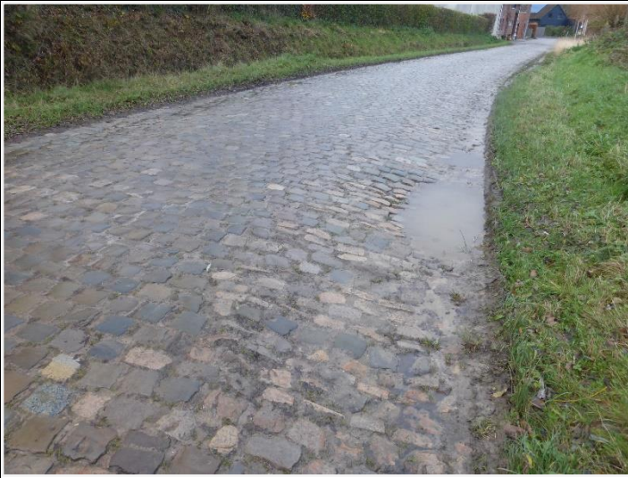
Foto 1: De kasseiweg met 4 m breed wegprofiel in de bocht.
