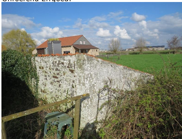
Foto 40 - Brouckmolen. Toegang tot oliekelder © 2024 Onroerend Erfgoed.
