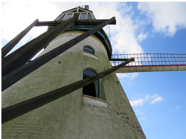
Foto 32 - Brouckmolen. Staart (korte en lange spruit met schoren) © 2024 Onroerend Erfgoed.
