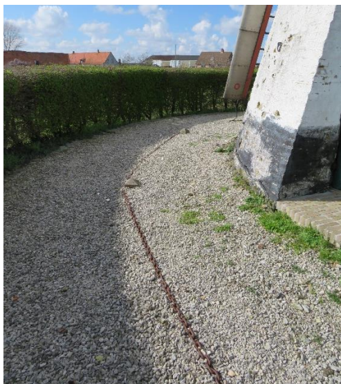
Foto 35 - Brouckmolen. Kruipalen met kruiketting © 2024 Onroerend Erfgoed.
