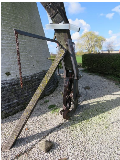
Foto 33 - Brouckmolen. Staart met uitwendig kruierwerk © 2024 Onroerend Erfgoed.
