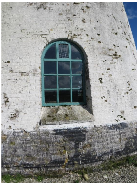
Foto 27 - Brouckmolen. Rondboogvensters op afzaat op gelijkvloerse verdieping. Gepikte plint © 2024 Onroerend Erfgoed.
