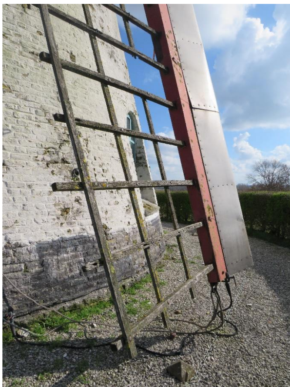
Foto 38 - Brouckmolen. Hekwerk gevlucht © 2024 Onroerend Erfgoed.
