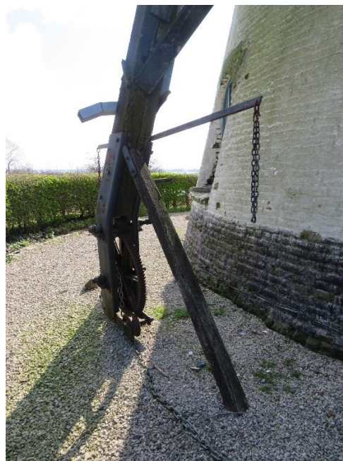
Foto 34 - Brouckmolen. Staart met uitwendig kruierwerk © 2024 Onroerend Erfgoed.
