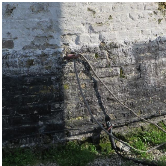
Foto 36 - Brouckmolen. Muurring © 2024 Onroerend Erfgoed.
